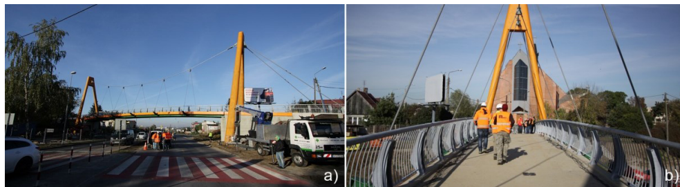
Fig. 7. Suspension footbridge in Radom over Szarych Szeregów street.
