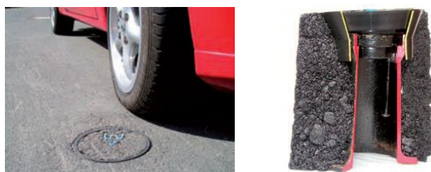
Abbildung 16: Lärmarme Schachtabdeckung [157]
