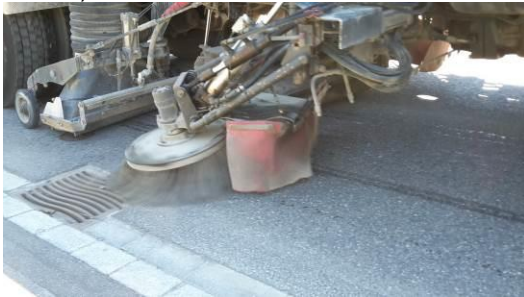
Abb. 4: Reinigungsverfahren kehren mit anschliessendem Absaugen
