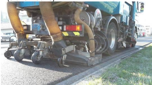
Abb. 6: Reinigungsverfahren Rotoplast mit anschliessendem Absaugen
