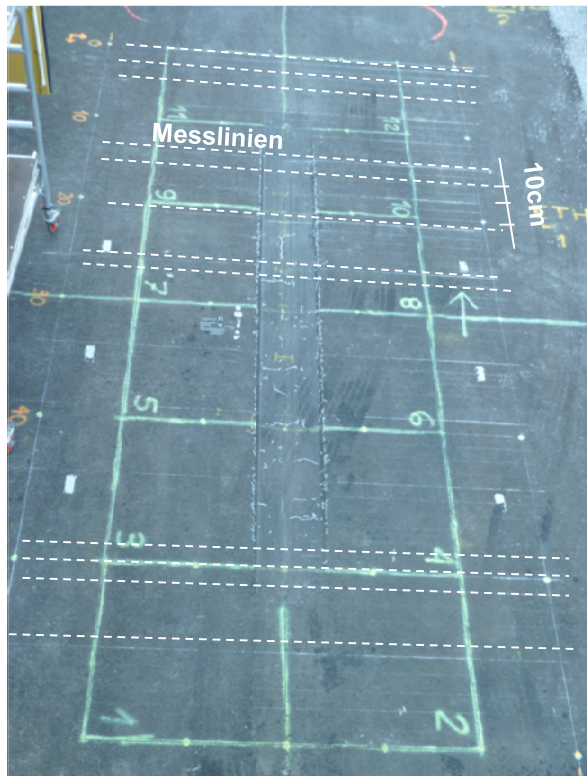
Abb. 15 Messgitter für die Inspektion des Belags mit Georadar
