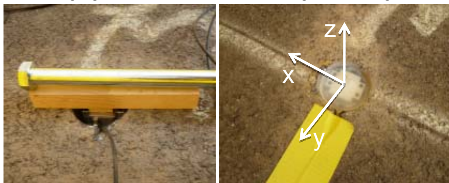
Abb. 9 Hilfseinrichtung zum Einbau der Beschleunigungssensoren (links) und eingebauter und vergossener Sensor mit Koordinatenrichtungen (rechts)
