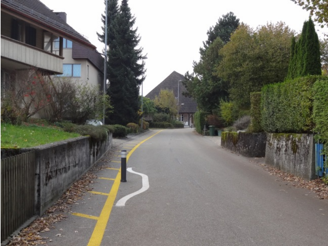
Abbildung 91 Wenn Poller ausserhalb der Fussgängerlängsmarkierung gesetzt werden, müssen sie durch eine Randlinie als Horizontalversatz gekennzeichnet werden. Dies führt zu einer besseren Wahrnehmbarkeit und senkt die Geschwindigkeit. (Archivbild verkehrsteiner AG)
