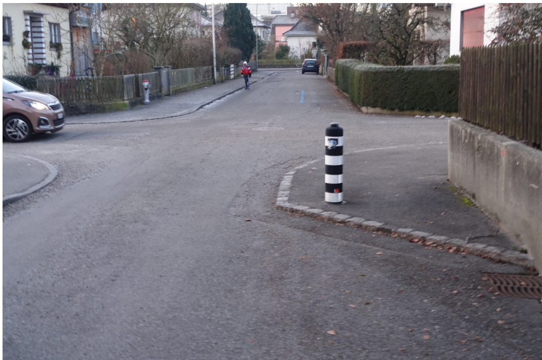
Abbildung 74 Köniz Liebefeld BE: Bei einer Strasse entlang des Schulhauses mit einseitigem Trottoir wurde auf der Gegenseite das Trottoir der Querstrasse um die Ecke gezogen. So haben Schulkinder (und übrige Fussgänger) vor dem Queren der Strasse Sicht auf herannahende Fahrzeuge und Fahrzeuglenkende können wartende Fussgänger rechtzeitig wahrnehmen. Ein reflektierender Poller stellt sicher, dass die Verengung auch nachts und im Winter bei Schnee rechtzeitig wahrgenommen werden kann. (Archivbild verkehrsteiner AG)
