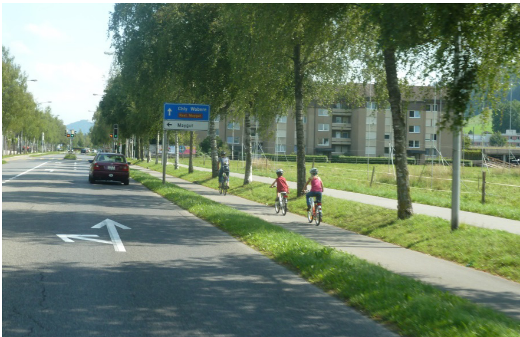
Abbildung 93 Köniz-Wabern BE: Entlang der Seftigenstrasse, einer wichtigen Ausfallachse ins Vorland der Stadt Bern, fühlen sich Velofahrende auf einem baulich abgetrennten Radweg sicher. Schnelle Velofahrende dürfen aber auch auf der Fahrbahn mit dem motorisierten Verkehr unterwegs sein. (Archivbild verkehrsteiner AG)
