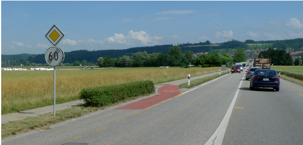
Abbildung 96 Auf der Ausserortsstrecke entlang der Hauptstrasse in Grenchen (SO) wird das Velofahren auf dem Trottoir zugelassen. Beim Ortseingang wird das Velo mit einer rot eingefärbten, abgesenkten Übergangszone in der Verlängerung des Trottoirs sicher auf die Fahrbahn zurückgeführt. So kann sichergestellt werden, dass Velofahrende nicht plötzlich und unverhofft vor Motorfahrzeugen in deren Fahrspur einschwenken. (Archivbild verkehrsteiner AG)
