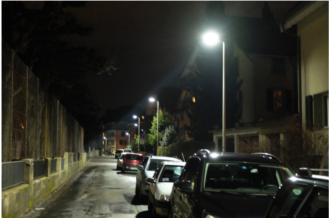
Abbildung 83 Bern Brunnmattstrasse: Neue LED-Leuchten führen zu einer guten, gleichmässigen und energiesparenden Ausleuchtung von Fahrbahn und Trottoir. Links im Bild sind der Sportplatz und dahinter das Schulhaus. (Archivbild verkehrsteiner AG)
