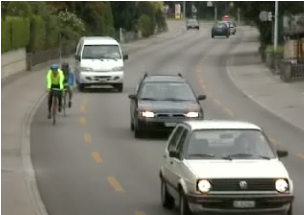
Abbildung 99 Bätterkinden BE: Markierung einer Kernfahrbahn entlang einer Kantonsstrasse mit Schülerverkehr bewirkt ein erhöhtes Sicherheitsempfinden der Velofahrenden und mehrheitlich gute Überholvorgänge (Videostandbild Archiv verkehrsteiner AG).
