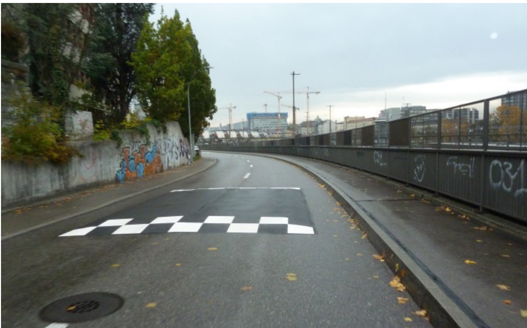
Abbildung 76 Bern Stadtbachstrasse: Ein Vertikalversatz („Berliner Kissen“) stellt auf einer Quartierstrasse mit regem Pendlerverkehr die Einhaltung der Geschwindigkeit sicher. Das Belagskissen geht nicht bis an den Fahrbahnrand, sodass die Entwässerung nicht unterbrochen wird und keine zusätzlichen Einlaufschächte erstellt werden müssen. Die Velofahrenden werden zudem weniger „ausgebremst“, da sie die Massnahme umfahren können. Allerdings können auch Motorräder am Kissen vorbeifahren und werden nicht zwingend gebremst. (Archivbild verkehrsteiner AG)
