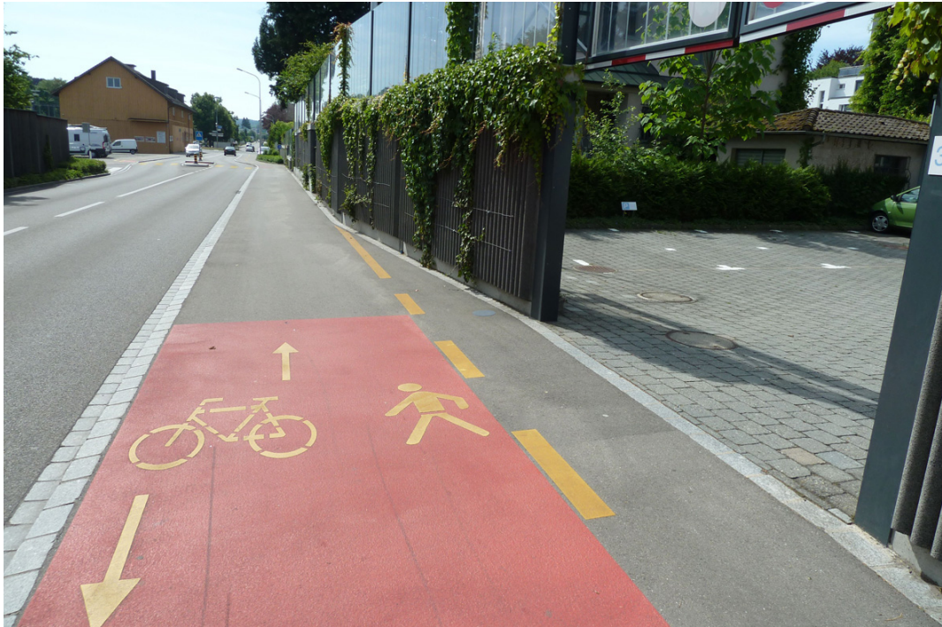
Abbildung 92 Trottoir das für Velos freigegeben wurde. Wenn ein Fussweg oder Trottoir für Velos freigegeben wird, kann dies zu Konflikten einerseits mit dem Fussverkehr, andererseits aber auch mit unerwartet schnellen Velos und aus einem Parkplatz ausfahrenden Autos führen. Diese Problematik wurde hier mit dem rot Einfärben der Gefahrenstelle und Piktogrammen entschärft. Zudem verbessert das leichte zurücksetzen der Lärm-schutzwand die Sichtverhältnisse. (Archivbild verkehrsteiner AG)
