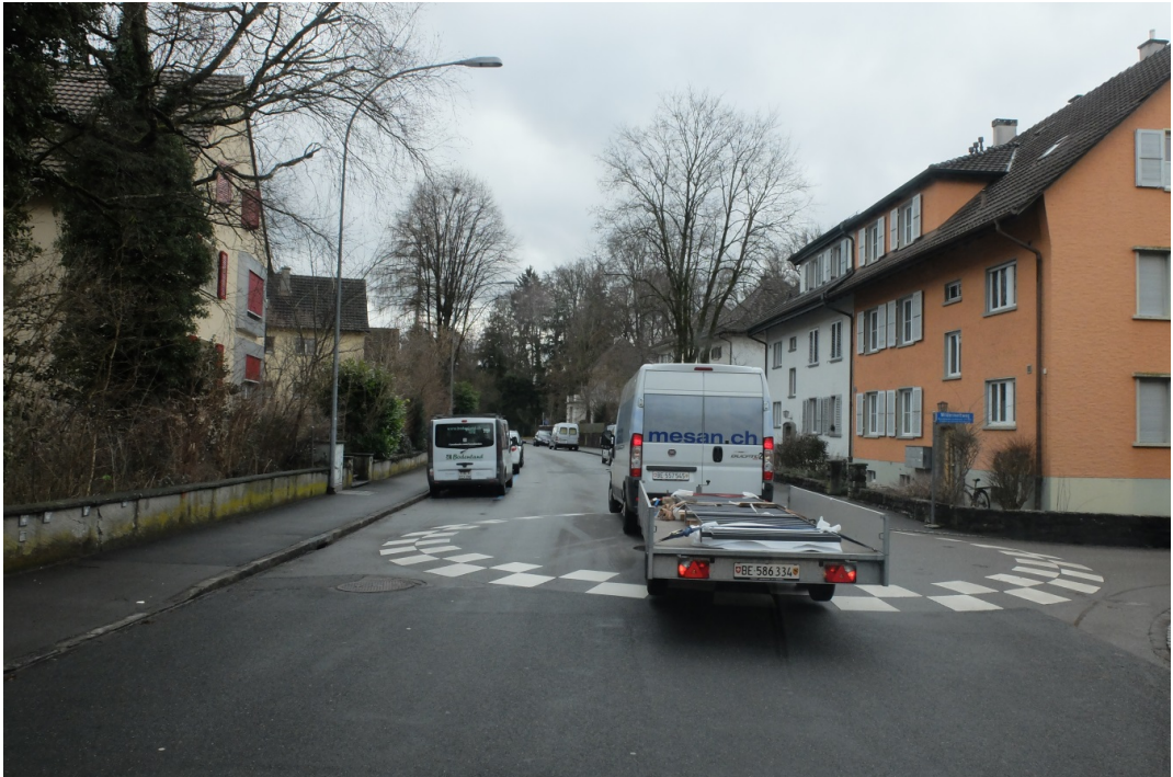
Abbildung 77 Bern Ensingerstrasse: Ein kreissegmentförmiger Vertikalversatz (Belegskissen) stellt auf einer Quartierstrasse die Einhaltung von Tempo 30 sicher. Dies ist billiger als das flächige Anheben des ganzen Kreuzungsbereichs, hat aber den Nachteil, dass im Winter beim Schneeräumen Restschneeflächen im Bereich der runden Rampen liegen bleiben, die vereisen können. (Archivbild verkehrsteiner AG)
