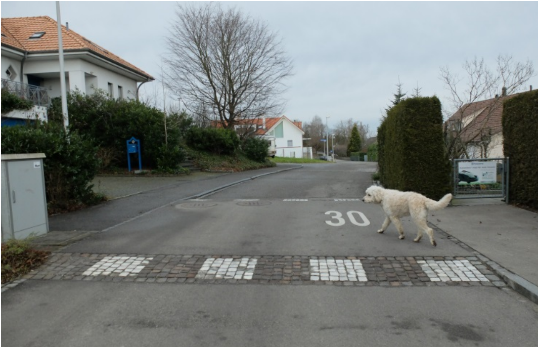
Abbildung 75 Kreuzlingen TG: Gut sichtbarer Vertikalversatz in einer Tempo-30-Zone. Der hell-dunkel Kontrast von Pflastersteinen aus Granit und Marmor hebt die Anrampung hervor. Die Verwendung von Pflastersteinen und vor allem Marmor bewährt sich aber nur bei sehr geringem Verkehrsaufkommen. Einerseits sind die Rollgeräusche nachteilig und andererseits ist die Lebensdauer beschränkt. In der Regel sind Rampen aus Schwarzbelag dauerhafter und die Schachbrettmarkierung stellt eine gute Erkennbarkeit sicher. (Archivbild verkehrsteiner AG)
