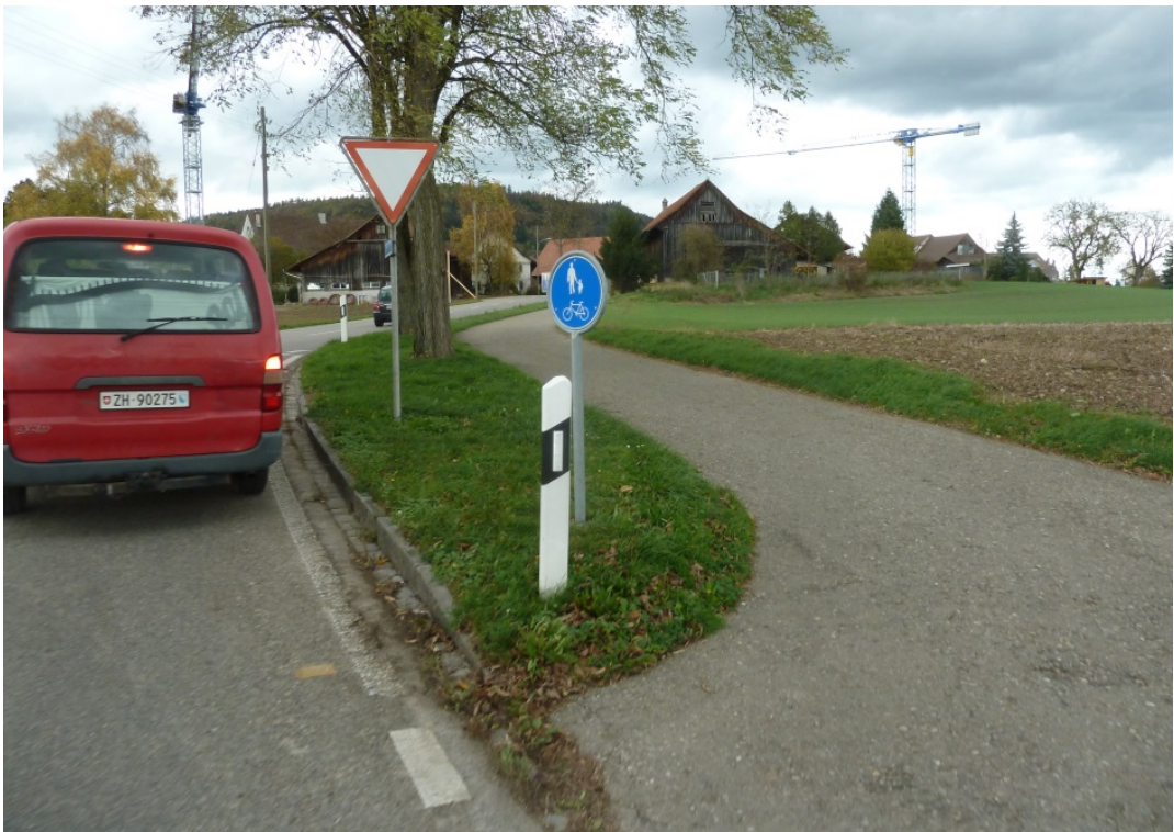
Abbildung 95 Fuss- und Radweg entlang der Überland-Kantonsstrasse zwischen Neerach und Stadel (ZH). Abgetrennte Fuss- und Radwege vermitteln den Velofahrenden ein höheres Sicherheitsempfinden und erlauben auch nebeneinander zu fahren. Sie sind aber nur dann sicher, wenn der Zugang resp. die allenfalls dazu notwendige Querung der Strasse sicher ausgestaltet werden können. (Archivbild verkehrsteiner AG)
