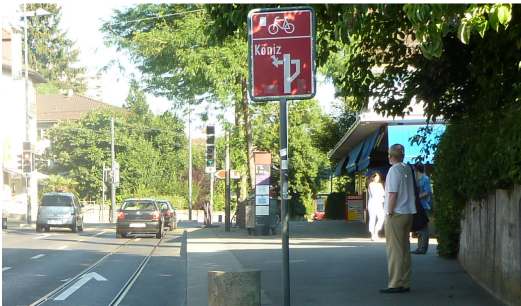
Abbildung 102 Wabern bei Bern: Durch die Ermöglichung von indirektem Linksabbiegen wird der Abbiegevorgang vereinfacht und die Sicherheit beim Queren der Fahrspuren und Tramgleise erhöht. Zudem wird ein geschützter Wartebereich für abbiegende Velofahrende angeboten. (Archivbild verkehrsteiner AG)
