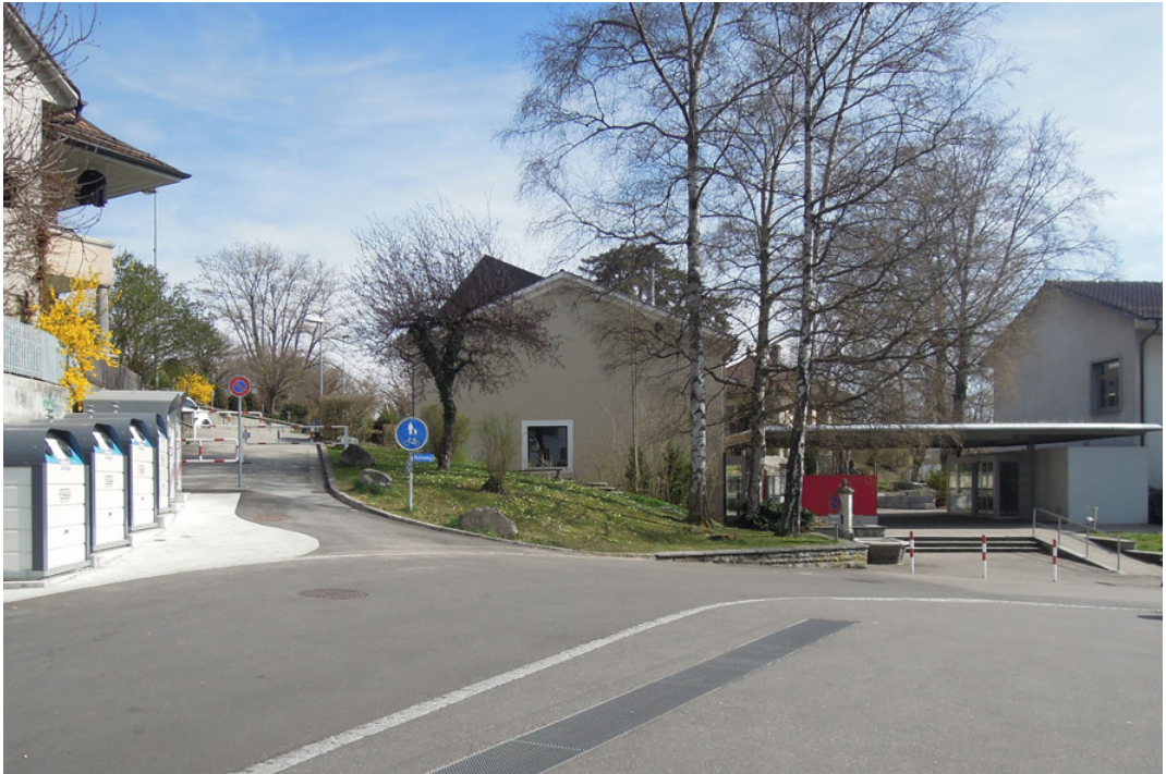
Abbildung 85 Muri BE: Foto des Nachherzustandes; die Büsche sind entfernt und die Sicht in der Kurve und auf das Schulhaus ist nicht mehr eingeschränkt. Die vorher heiklen Begegnungsfälle von Autos und Kindern, die mit dem Velo abwärts zur Schule gelangen, sind eliminiert. Der Durchgang ist nur noch für Zufussgehende und Velofahrende passierbar. Metallschranken reduzieren die Geschwindigkeit der Velos. (Archivbild verkehrsteiner AG)
