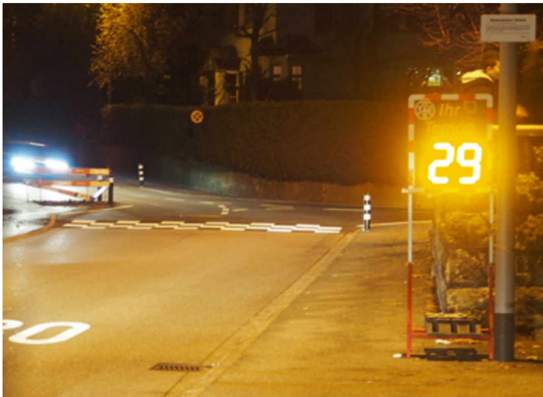
Abbildung 110 Schönenwerd SO: Vor dem Schulhaus unterstützt ein Inforadar die Einhaltung der Geschwindigkeit in der neu gestalteten Tempo-30-Zone. Im Bildhintergrund ist ein Vertikalversatz zu sehen, der die Verkehrssicherheit beim Hauptzugang zum Schulhaus erhöht (Archivbild verkehrsteiner AG).
