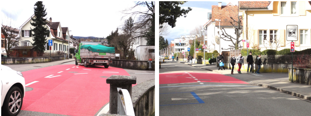
Abbildungen 22 und 23 Betonung des Rechtsvortritts auf der Sammelschulroute Gartenstrasse mittels „Tulpe“ und roter Farbgestaltung. (Archivbilder Gemeinde Aesch, 2012)
