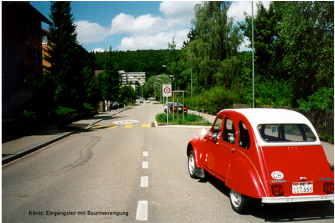
Abbildung 73 Köniz: Ein markantes Eingangstor mit starkem Horizontalversatz stellt auf der geraden und breiten Quartierstrasse sicher, dass die Tempo-30-Zone bei der Einfahrt ab der Hauptstrasse besser wahrgenommen und eingehalten wird. (Archivbild verkehrsteiner AG)
