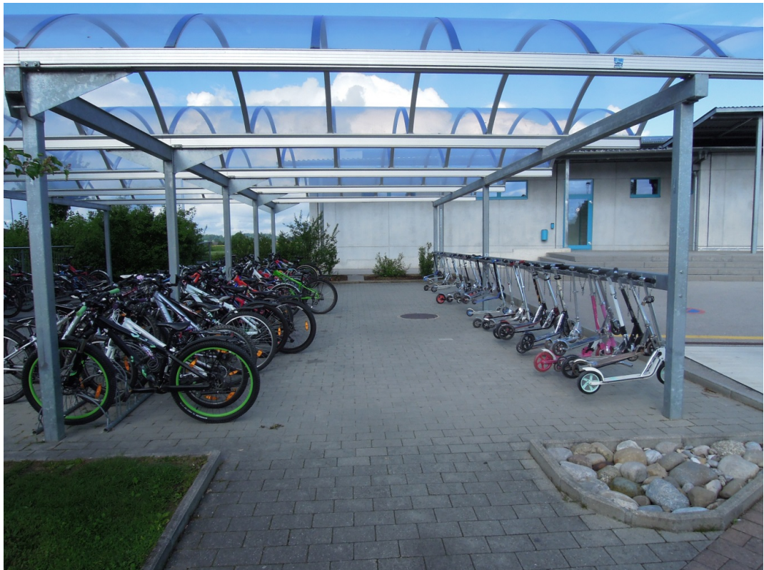
Abbildung 104 Wünnewil-Flamatt FR: zweckmässige Velo- und Kickboardabstellanlage (Archivbild verkehrsteiner AG)
