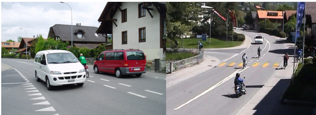
Abbildungen 100 und 101 Steffisburg BE Zugstrasse: Eine Abbiegehilfe (mit Leitlinien markierter Bereich in der Fahrbahnmitte) erleichtert den Schulkindern auf dem Velo das Einspuren in Strassenmitte und Abbiegen zum Schulhaus. (Archivbilder verkehrsteiner AG)
