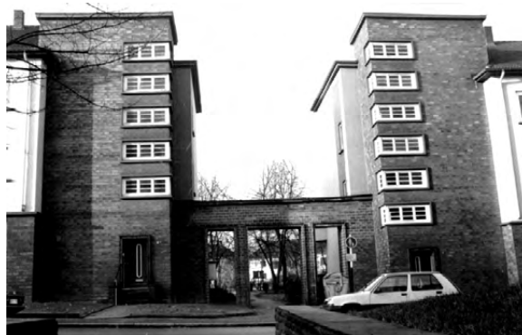
Abb. 33 Ansicht Toranlage Püttmannsweg
