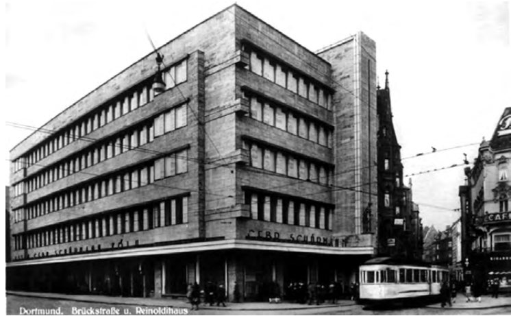
Abb. 62 Ansicht Kampstraße Ecke Brückstraße
