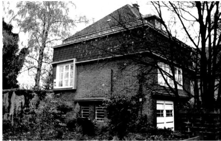
Abb. 91 Südostansicht auf Garage und Praxis
