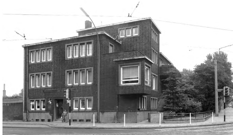
Abb. 61 Ansicht Gneisenaustraße Ecke Clemens-Veltum-Straße
