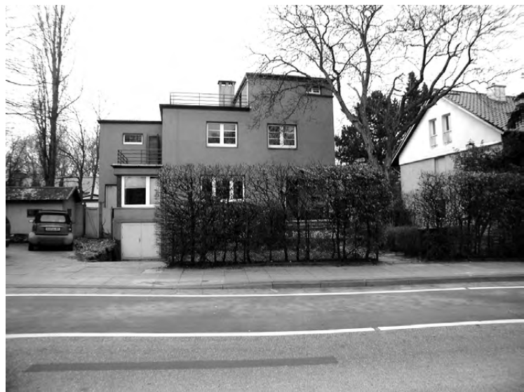
Abb. 26 Ansicht Voltmannstraße (mit Erweiterungen)
