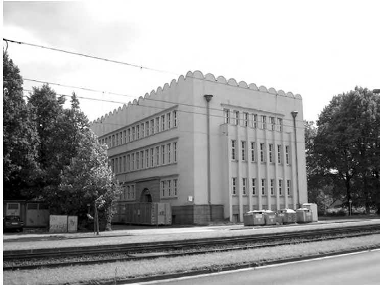
Abb. 40 Ansicht Essener Straße
