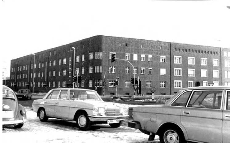
Abb. 105 Ansicht Grünstraße Ecke Richard-Wagner-Straße
