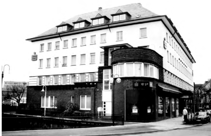
Abb. 83 Ansicht Mittelstraße von Süden
