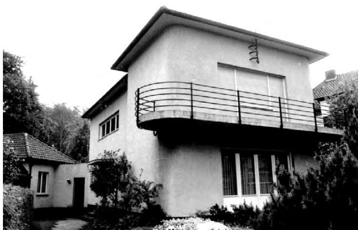
Abb. XXV Gütersloh, Dalkestraße 9, Haus Westerbarkey
