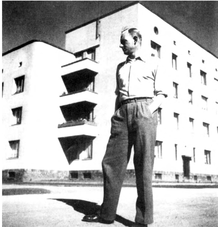
Abb. 102 Ansicht Schillerstraße Ecke Wielandplatz
