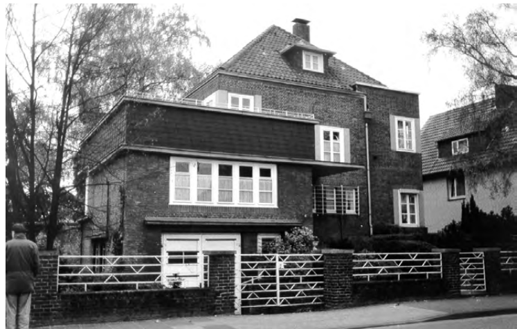
Abb. 90 Ansicht Paderborner Straße
