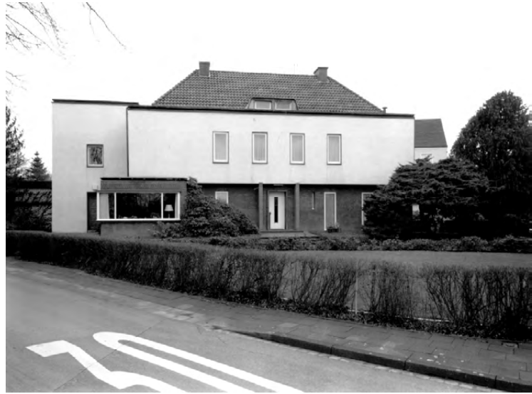
Abb. 199 Ansicht Am Weingarten / Warendorfer Straße
