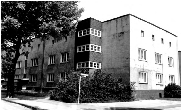
Abb. 55 Ansicht Huckarder Bruch 11
