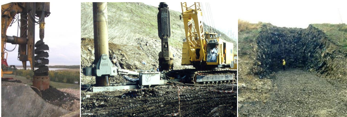
Abbildung 2-2: Schneckenbohrung, Greiferbohrung und Großschurf in Hausmülldeponien
