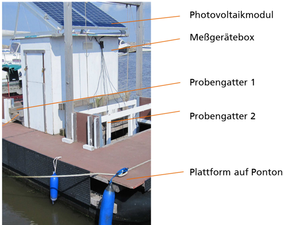
Abb. 8 Seewasserteststand mit photovoltaischer Strom- und Landstromversorgung, Bootshafen Kühlungsborn.
