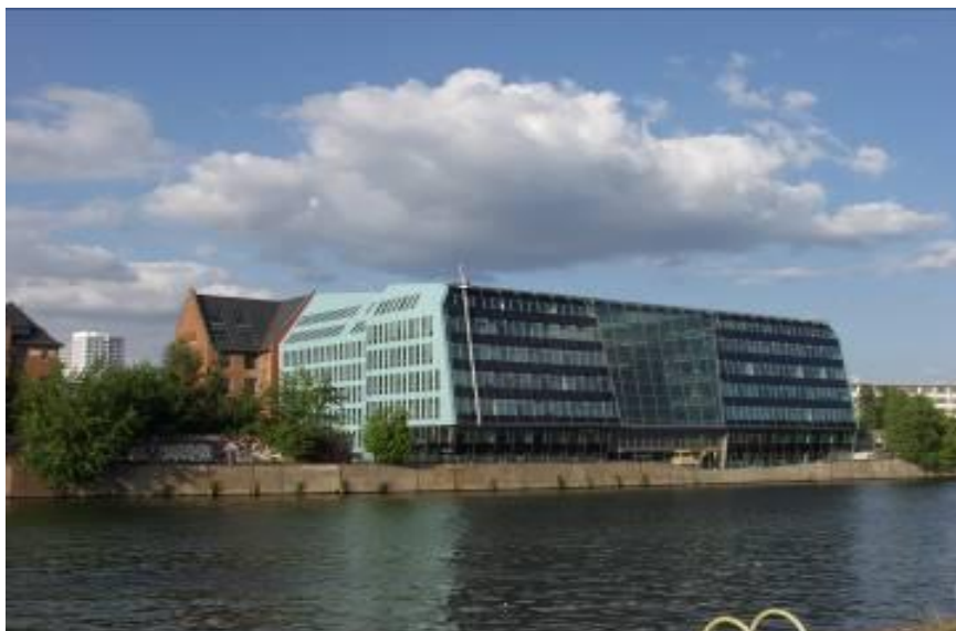
Abbildung 1 Integrale Planung - Schlanke Gebäude: Das EnergieForum Berlin (Foto: IGS)
