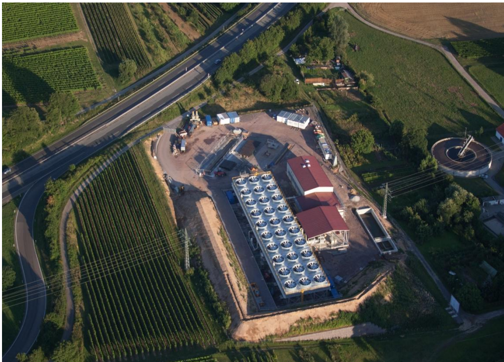
Das Geothermiekraftwerk Insheim
