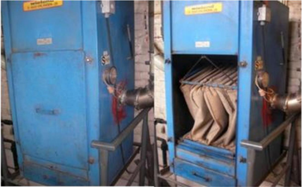
Abbildung 84: Sackfilter im geschlossenen (links) und geöffneten Zustand (rechts)
