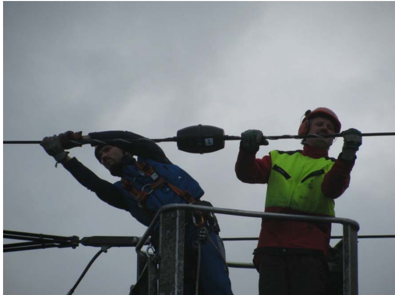
Abbildung 2.6.28: Montage der Sensorknoten auf 110-kV-Leitung
