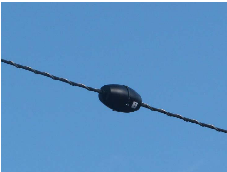
Abbildung 2.5.11: Montage des ASTROSE-Sensorknotens
