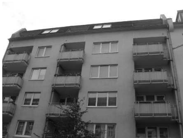
Abb. 3.5: Beispiel für eine Außenfassade im untersuchten Nahwärmenetz
