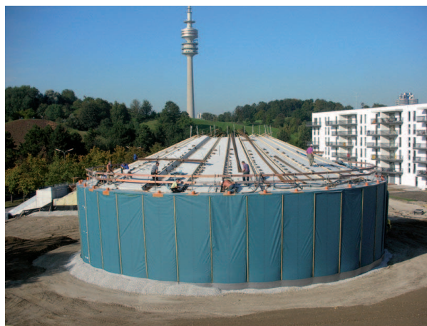
Abb. 5.3: Heißwasser-Wärmespeicher in München, Abbildung aus [2])
