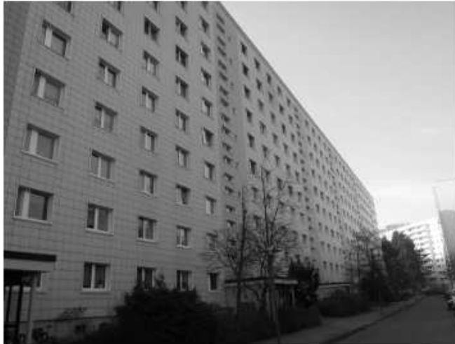
Abb. 3.8: Beispiel für einen Wohnblock im untersuchten Fernwärmenetz
