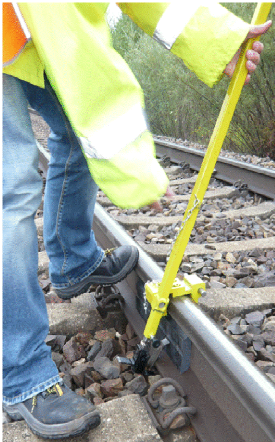
Abb. 2.14a: Der Prototyp des Einbauwerkzeuges wurde beim Einbau der ersten Dämpfervarianten im Rangierbahnhof München-Nord erprobt und konnte anhand dieser Erfahrungen weiter verbessert werden.
