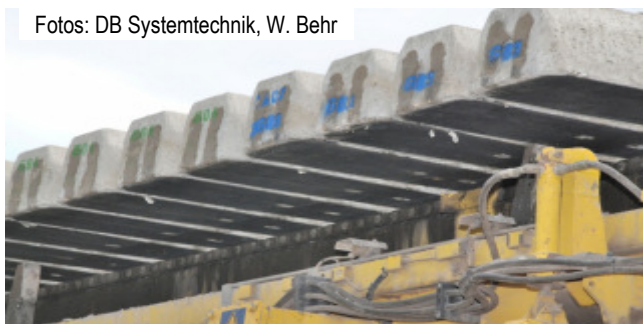
Abb. 2.65: Beim Einbau der beschlittenen Schwellen wurde die deren Reihenfolge und Verlegeort überwacht.
