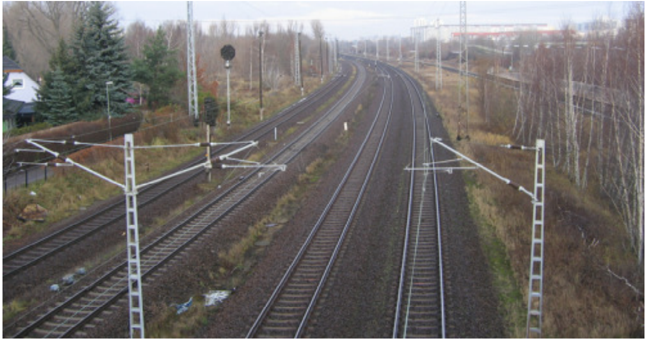
Abb. 2.62: Neben der mehrgleisigen Strecke 6067 bei Berlin verliefen auch seitlich teils stark befahrene Straßen, so dass diese Strecke nicht als Testabschnitt verwendet werden konnte.
