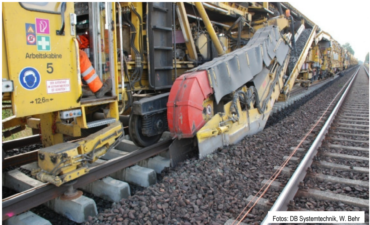
Abb. 2.64: Der Einbau der beschlittenen Schwellen erfolgte mit einem kilometerlangen Spezial-Einbauzug.
