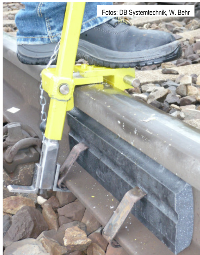
Abb. 2.14a: Der Prototyp des Einbauwerkzeuges wurde beim Einbau der ersten Dämpfervarianten im Rangierbahnhof München-Nord erprobt und konnte anhand dieser Erfahrungen weiter verbessert werden.
