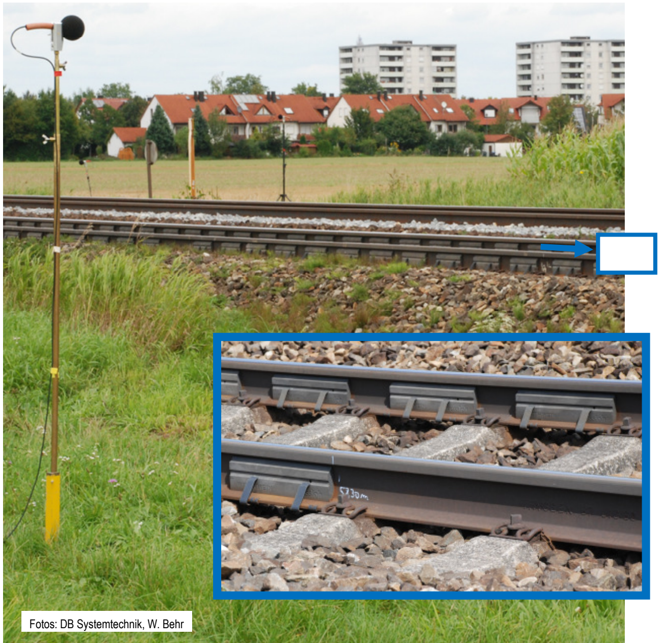
Abb. 3.8a: Bei der Teststrecke nahe Langweid standen drei unterschiedliche Streckenabschnitte zur Verfügung: ein reales Gleis mit Schienenstegdämpfern (im Bild das vordere Gleis) sowie ein TSI-Abschnitt (im Bild das hintere Gleis).
