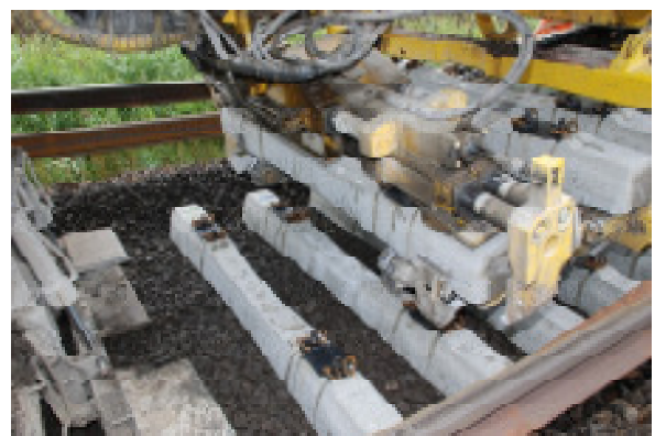
Abb. 2.65: Beim Einbau der beschlittenen Schwellen wurde die deren Reihenfolge und Verlegeort überwacht.
