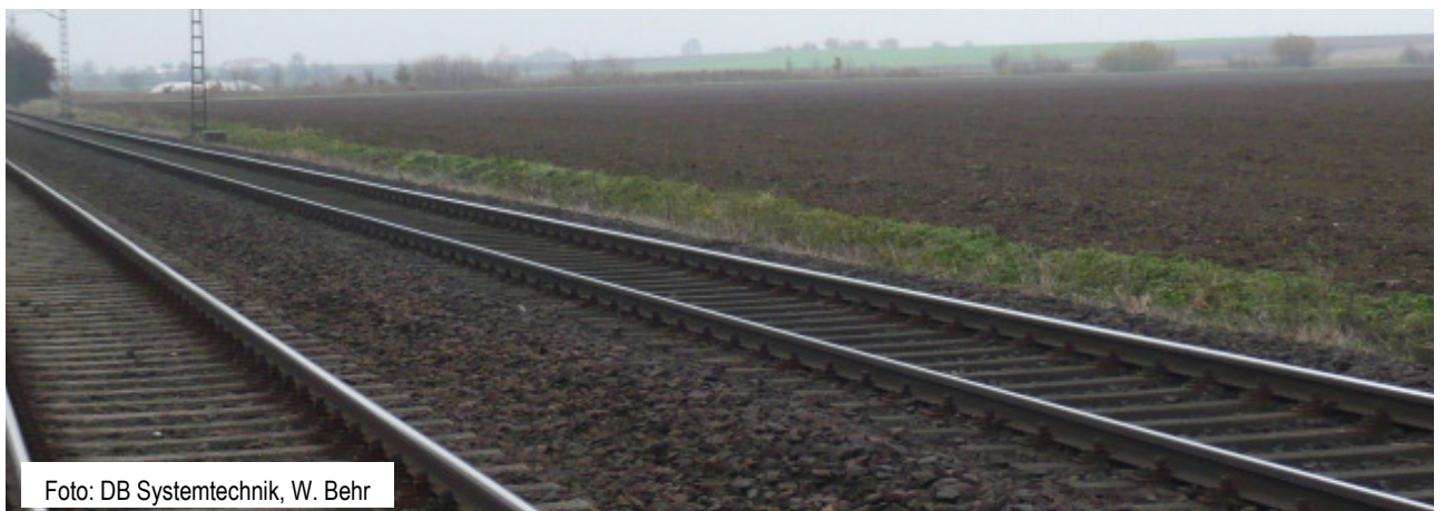
Abb. 2.63: Der Streckenabschnitt Mangolding – Sünching bei Regensburg erfüllte alle Anforderungen einer Teststrecke (gerade Strecke, geringe Dammlage, Zugänglichkeit bis zum Gleis, keine Störquellen aus Sicht von Akustik und Erschütterungen, ...) und wurde daher zum Einbau der beschlittenen Schwellen ausgewählt.
