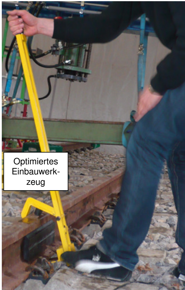
Abb. 2.14b: Das weiterentwickelte Einbauwerkzeug zur Montage der Dämpfer zeigte deutliche Vorteile bzgl. des ersten Prototypen des Einbauwerkzeugs.
