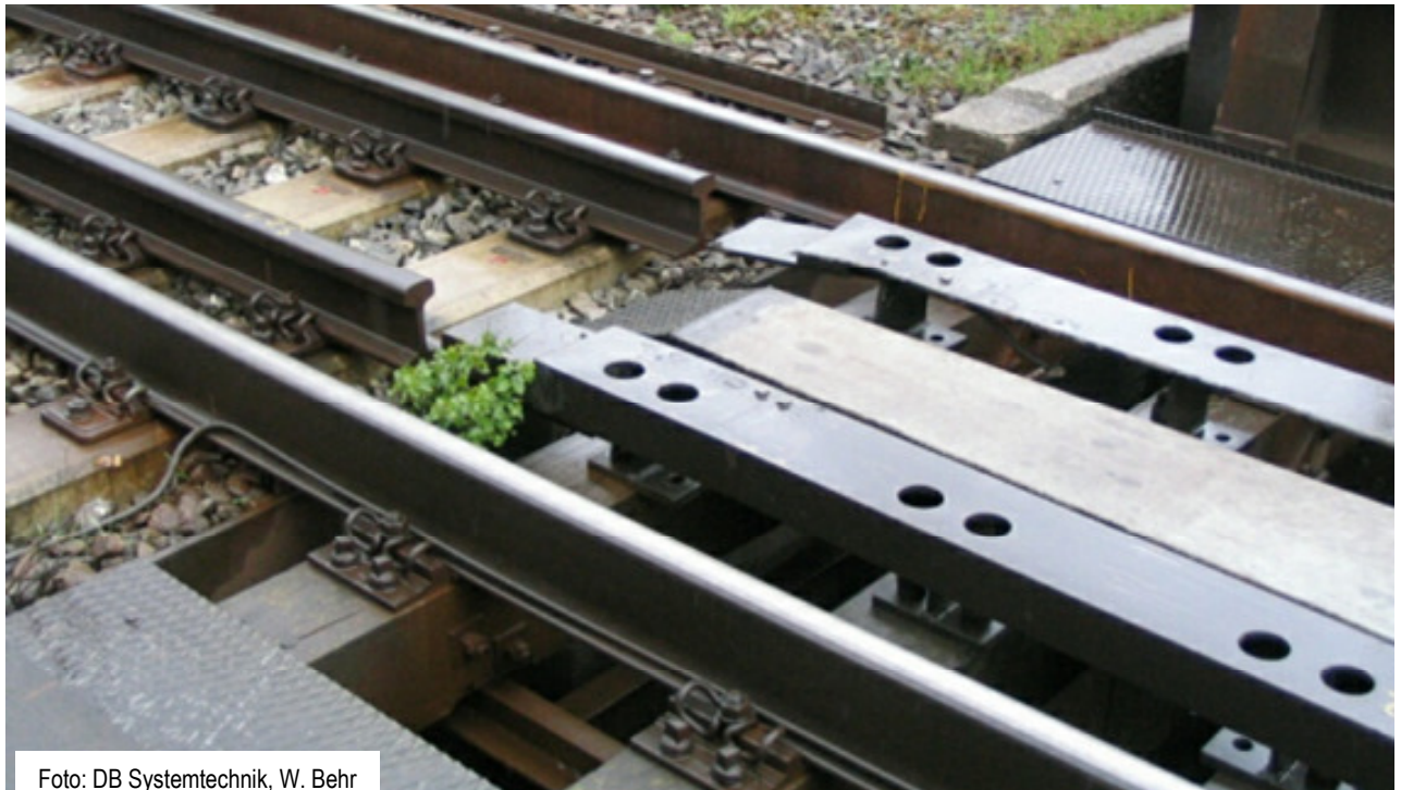
Abb. 2.40b: Detailansicht des Oberbaus der Brücke und der freien Strecke im Übergangsbereich
