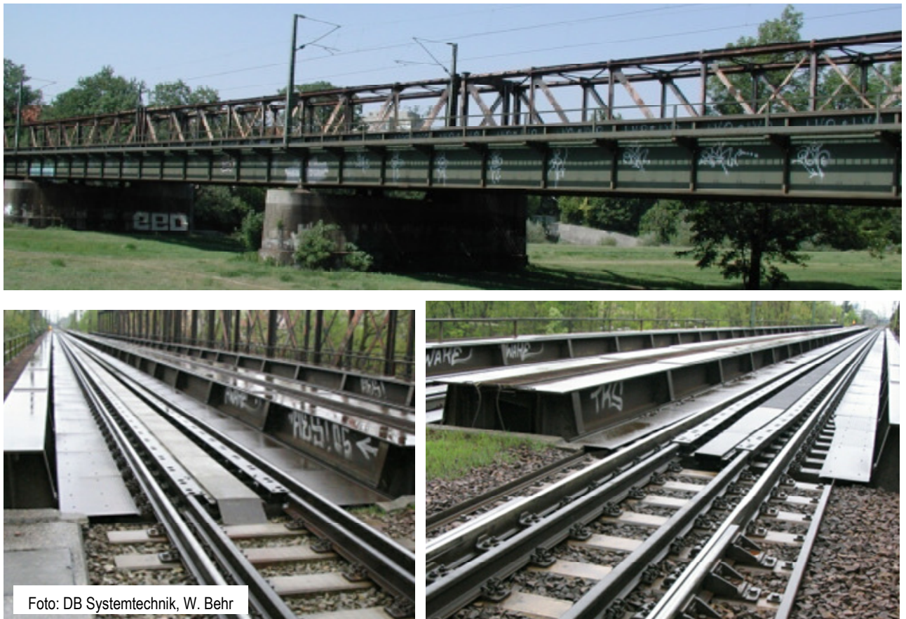
Abb. 2.40a: Zu Projektbeginn erschien die Braunauer Brücke in München zum Einbau und Test der hochelastischen Schienenbefestigung geeignet, deren Umbau im Jahr 2009 vorgesehen war. Das obere Foto zeigt die seitliche Gesamtansicht, die unteren Fotos zeigen die Draufsicht von beiden Brückenköpfen aus.
