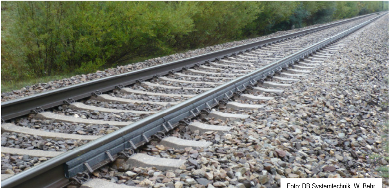
Abb. 2.12a: Prototyp „Schienendämpfer lang mit Koppelschicht, kontinuierliche Montage“
