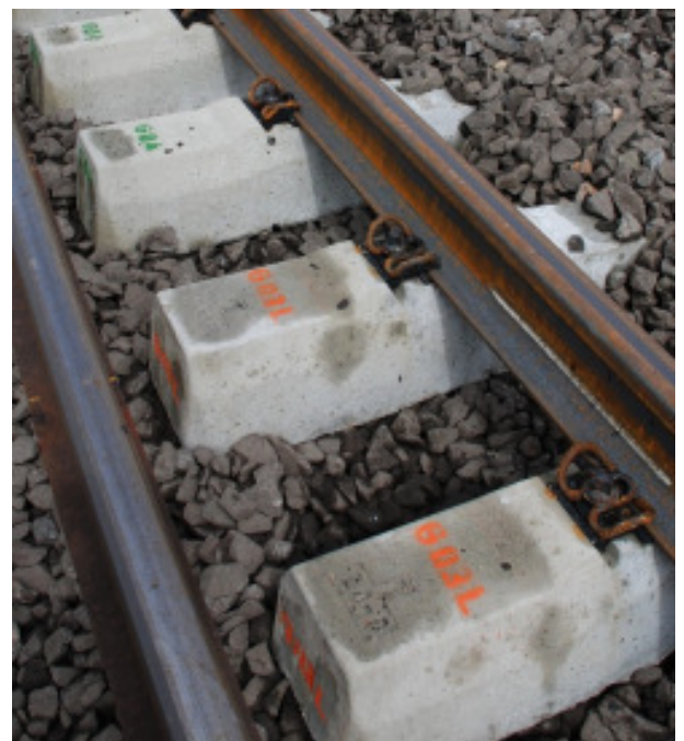
Abb. 2.66: Die besohnten Schwellen waren farblich markiert und mit Gravurschrift versehen.
