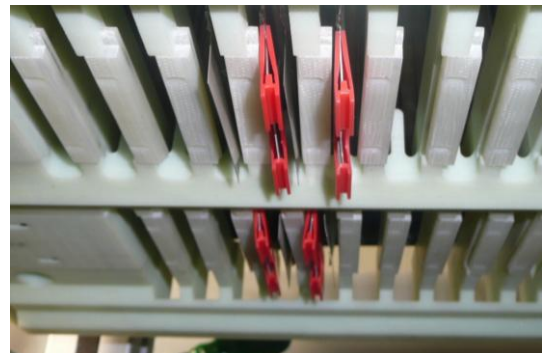
Abbildung 141: Möglichkeit der manuellen Entnahme des Ableiterschutzes mittels Kipp-Dreh-Einrichtung.
