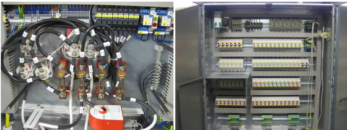
Abbildung 204: Messtechnik am stationären Prüfstand
