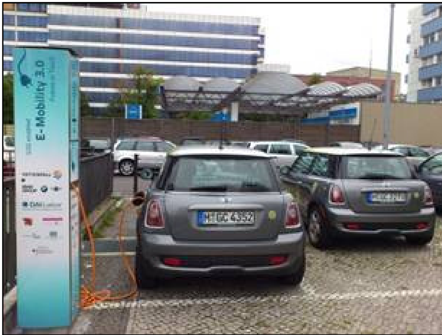
Abbildung 217: V2G-fähige Ladestation und MINI E im Freilandlabor
