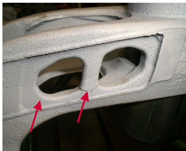
Abb. 102: Anrisse im Steg zwischen den Aussparungen bei der gewichtsoptimierten Variante
