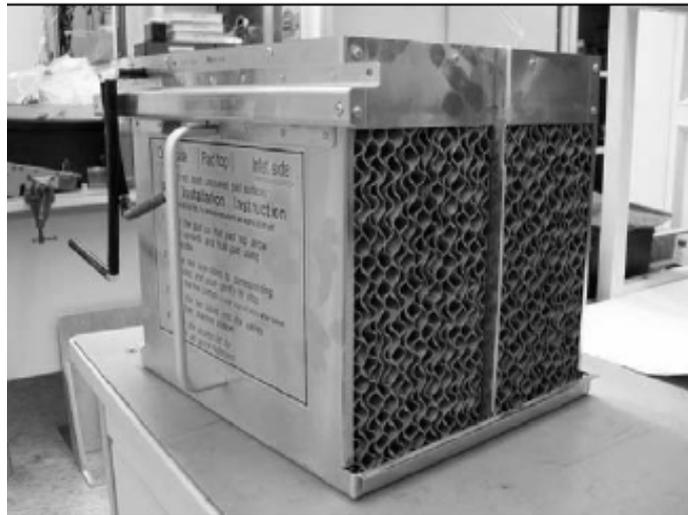
Abb. 6.5-7: „Pad“ eines Luftbefeuchters bestehend aus Glasfasermatten zur kalten Verdunstung
