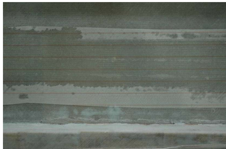
Abbildung 3-39: Großflächige Delaminationen der Sensorfaser-Abdeckung
