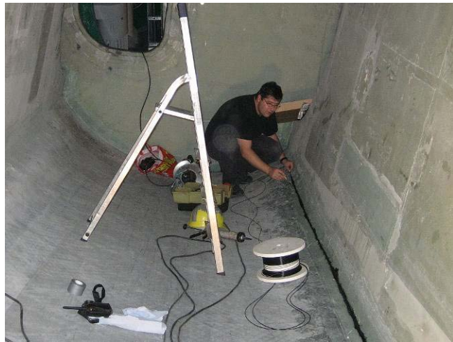
Abbildung 3-9: Installation der LWL-Verbindungskabel zwischen Sensoranschlussboxen im Blatt und Geräteschrank in der Nabe.
