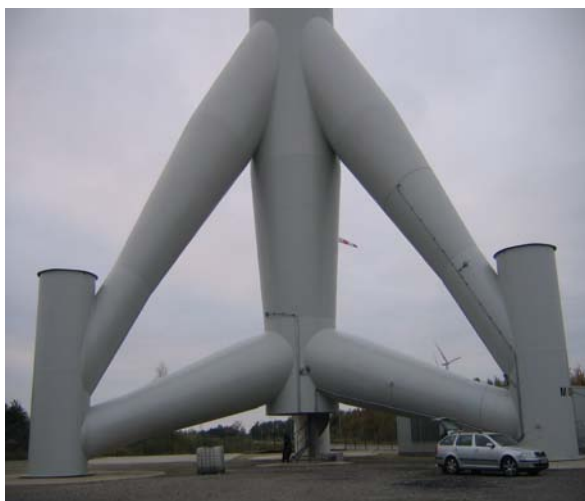
Abbildung 1-9: Tripod-Fundament M5000_2 <Bild links>; „ \mu -Bridge“ am Rotorlager der Offshore WEA M5000_2 <Bild rechts>
