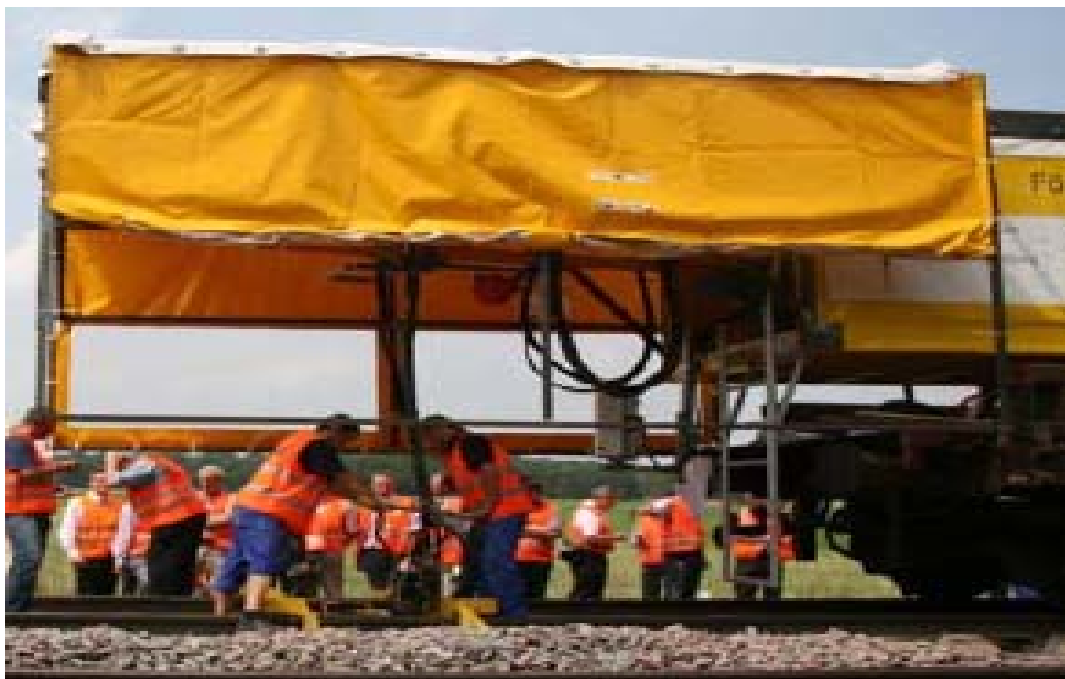
Abbildung 17: Einbringung des Schaums („Durflexisierung“)
