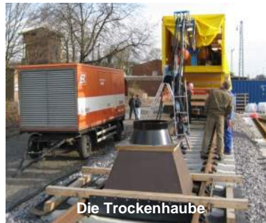
Einbau Glasschwellen
