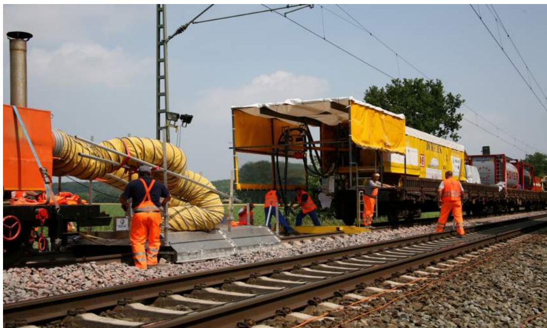
Abbildung 13: Einbauszug bestehend aus Heizhaube, Verschäumungseinheit und Versorgungstanks
