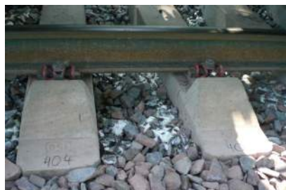
Das verschäumte Gleis
