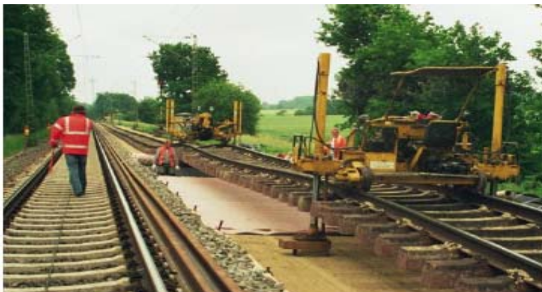
Abbildung 16: Einbringungsverfahren für zusätzliche Drän- bzw. Unterschottermatte
