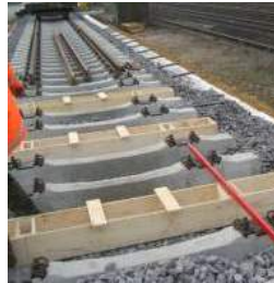
Einbau Glasschwellen
