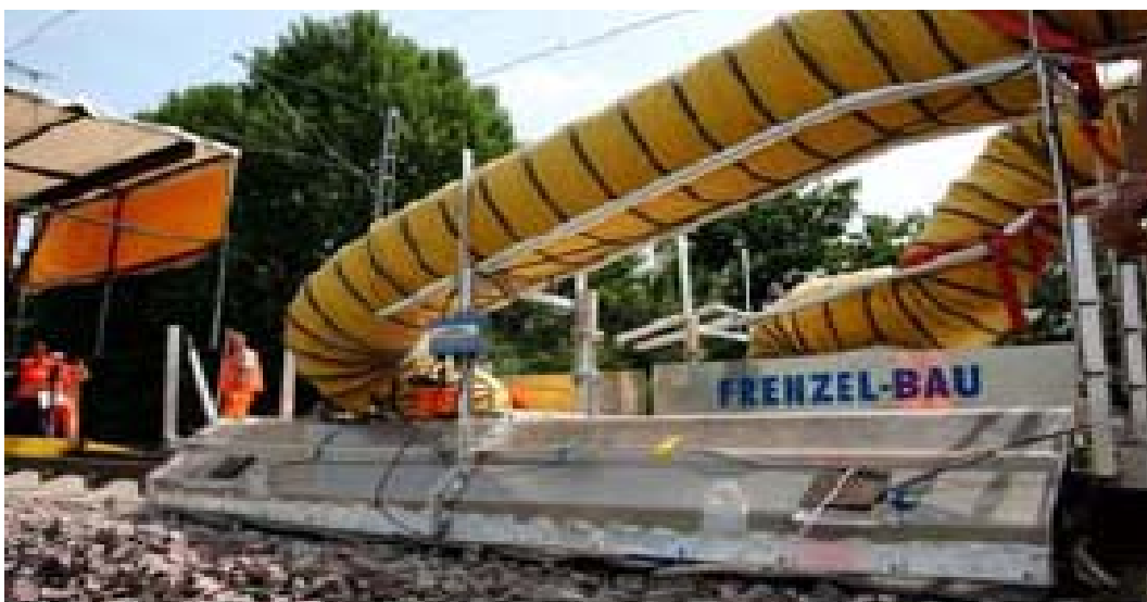
Abbildung 12: Heizhaube zur Vortemperierung des Schotterbetts
