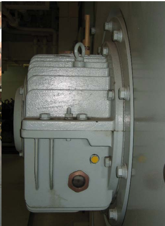
Abbildung 4 – Generator BS-Lager
