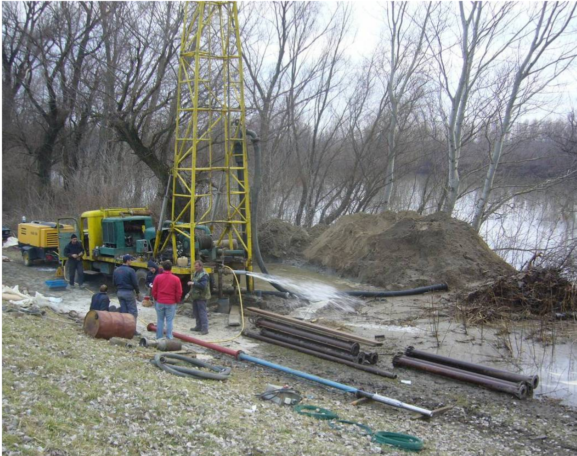
Abbildung 13: Bau des Versuchsbrunnens IEBP 1 an der Theiß bei Padej
