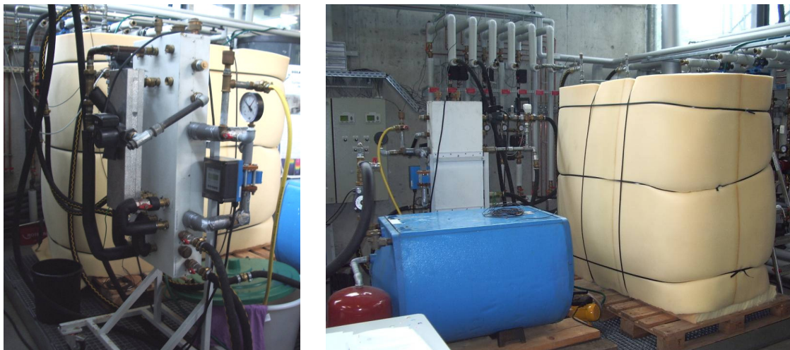
Abbildung 4: Hydraulik und Messtechnik (links) sowie Aufbau des Latentspeichers am Prüfstand (rechts)
