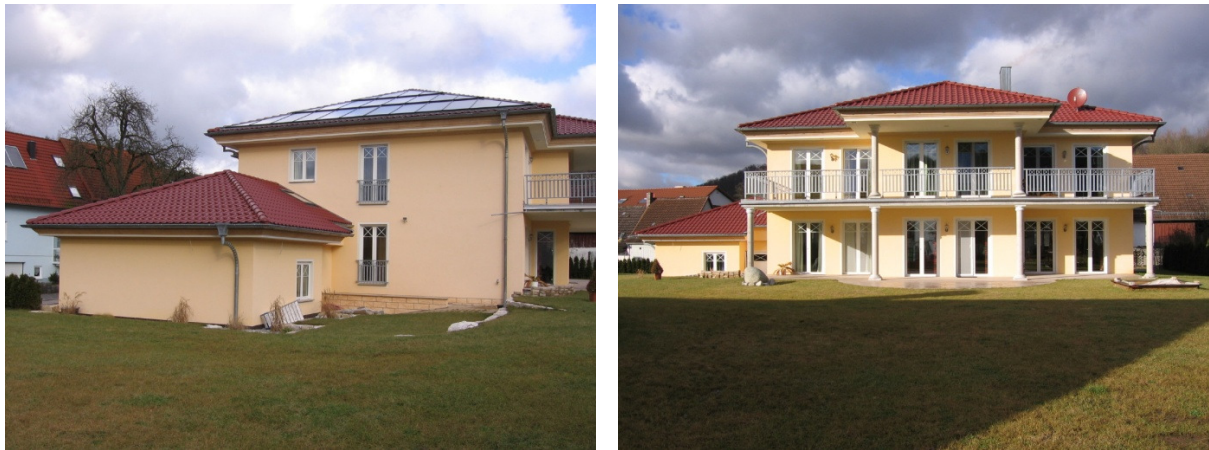
Abbildung 16: Südwest- und Südostansicht des Feldtestobjektes
