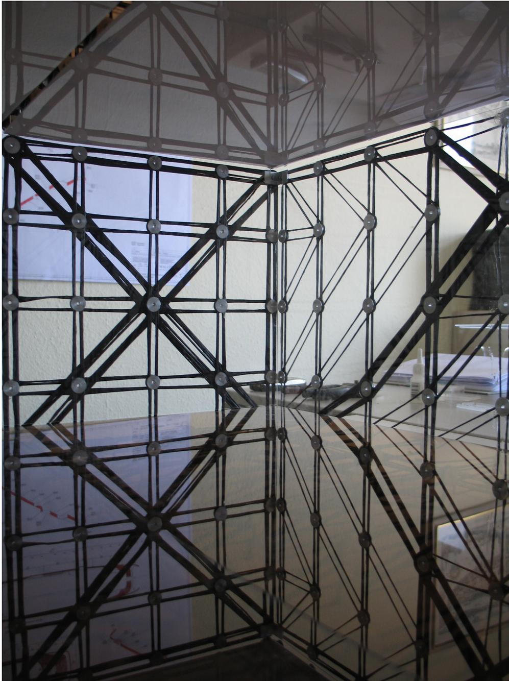
**Bild 3.6.6** Blick in eine Raumzelle mit Stützstruktur hinter Boden-, Decken- und Wandplatten
