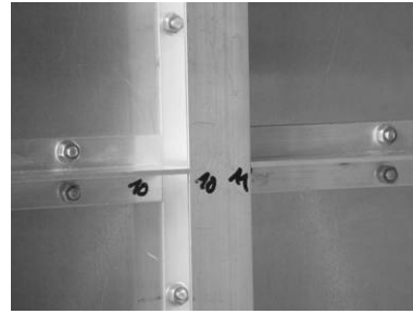
Fig. 3: Stiffener detail
