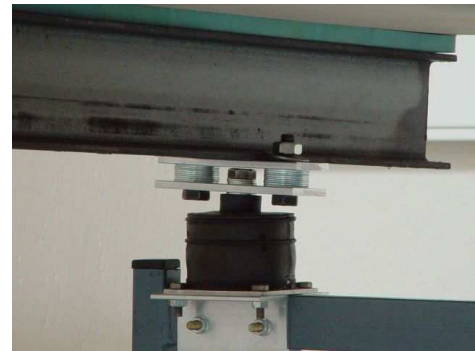
Bild 10: Entkopplung der Stahlträger durch Luftfedern
