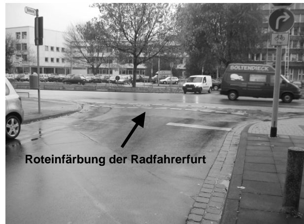
Bild 7.39: Blick aus der Escherstraße in die Brühlstraße nach Umsetzung der Maßnahmen nach HONIG (2004)
