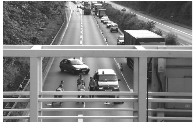
Bild 5.100: Absperrung bei der Montage der Messplatten nach SCHNÜLL, HOFFMANN, KÖLLE, MENNICKEN (2000)
