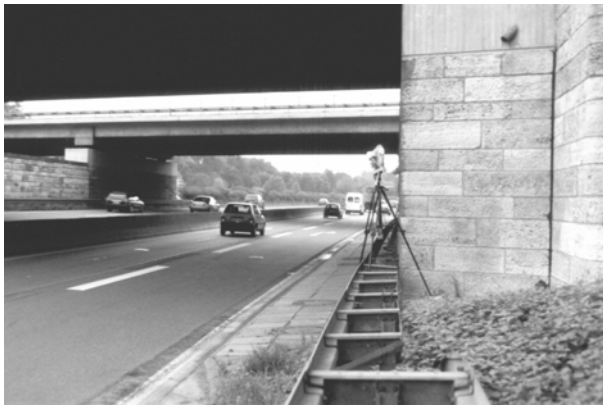
Bild 5.79: Stationäre Videoanlage in der unten im KP liegenden Verflechtungsstrecke des AK Köln-Süd
