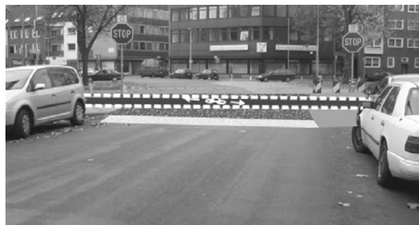
Bild 7.48: Blick aus der Welfenstraße in die Hamburger Allee mit der vorgeschlagenen Teilaufpflasterung im Einmündungsbereich nach HONIG (2004)
