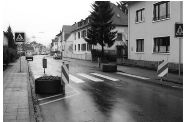
Bild 7.23: Fußgängerüberweg mit beschilterter Einengung und Pflanzkübeln nach MENNICKEN (1999)
