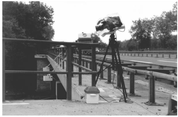
Bild 5.80: Stationäre Videoanlage oberhalb der unten liegenden Verflechtungsstrecke des AK Köln-Süd
