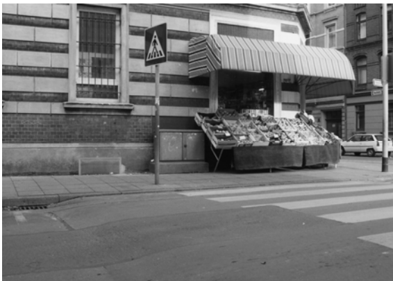
Bild 7.20: Fußgängerüberweg mit Teilaufpflasterung nach MENNICKEN (1999)
