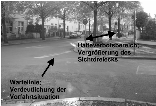
Bild 5.117: Blick in die Schackstraße nach Umsetzung der beschlossenen Maßnahmen nach HONIG (2004)
