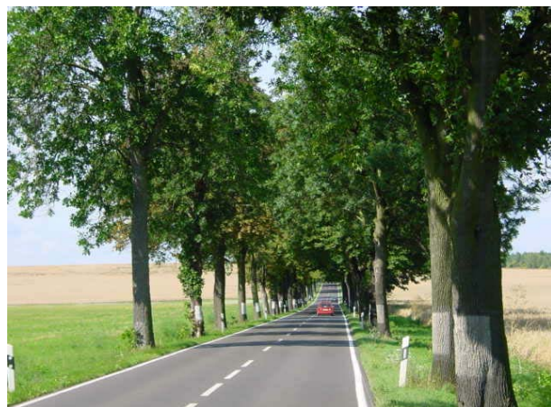
Bild 4.41: Erscheinungsbild der B246 mit Allee in Brandenburg zwischen dem Ortsende Teitz und einer Einmündung
