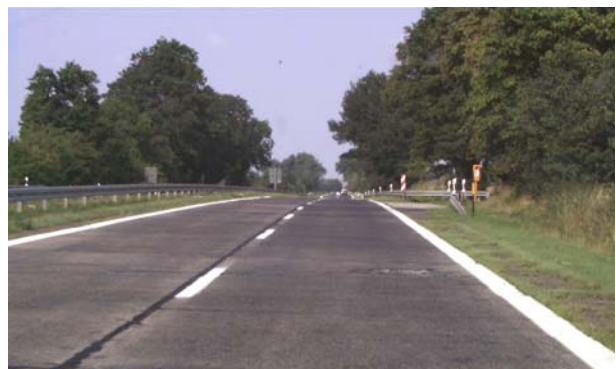
Bild 5.125: Außerortsstraße mit „Flattern“ in der Gerade durch die Abfolge Kuppe, Wanne, Kuppe
