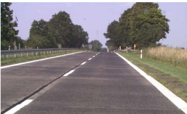
Bild 5.124: Außerortsstraße mit Kuppe
