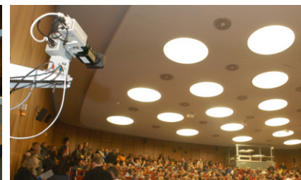
Hörsaal: eine von drei fernsteuerbaren PTZ-Kameras (hinten rechts: Regieraum)
