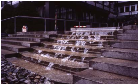
Abbildung 181: Wassertreppe der Allianzversicherung
