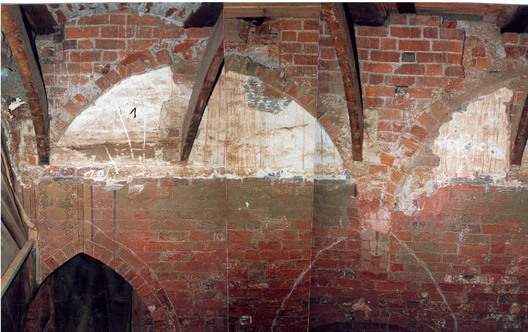
Abb. 58: (zusammengesetztes Foto) Nordwand des Nordkreuzganges, Schildbögen (1. von Westen) des ehemaligen, 1721 abgebrochenen Kreuzrippengewölbes; Konsole zwischen 1. und 2. Schildbogen stützt sich in Zumauerung der 3. Spitzbogennische (s. Plan 56)
