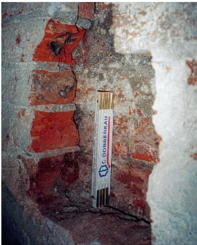
Abb. 102: Öffnung der Vorsatzschale im *A. Refektorium* zwischen den Schranknischen 7 und 8
