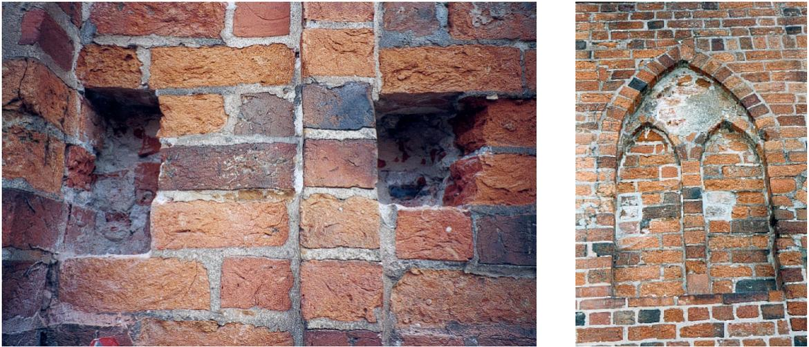
Abb. 68 und 69: 1. Maßwerkfenster von Osten, linke Öffnung zeigt in Mittelschicht den abgestemmtten Binder und auch zwei Schichten höher zeigt die in der Laibung liegende Fuge, dass es sich wieder um einen Binder handelt; demzufolge waren die Lanzetten von Anfang an nur als Blenden angelegt; die ursprüngliche Gipsschlämme ist hier im Gegensatz zum 6. und 11. Fenster bereits abgewittert
