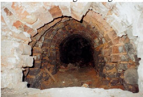
Abb. 32: L.S. West, K15, Feuerungsluke mit dahinter liegender Brennkammer
