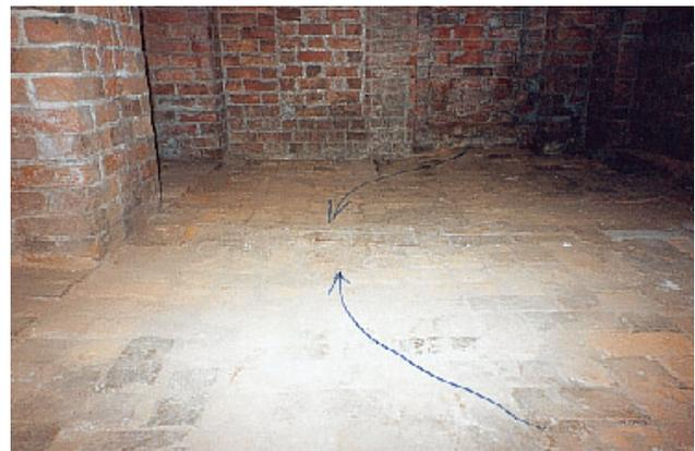
Abb. 89: E29, Blick nach Osten: Die Pfeile weisen auf Verschleißspuren im Fußboden hin; zwischen ihnen und an dem Pfeiler links die 1 Stein breiten Spuren (Pfeile) der ehem. Trennwand (mit Sprechfenster)
