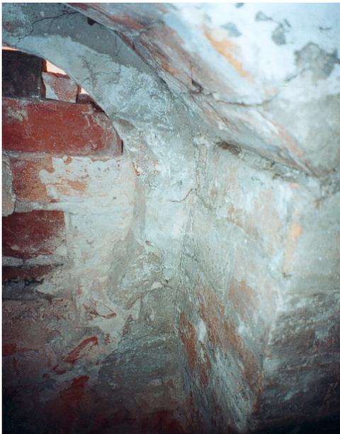
Abb. 72: Gipsschlämme auf Oculus und Zwickel der Lanzettspitze
