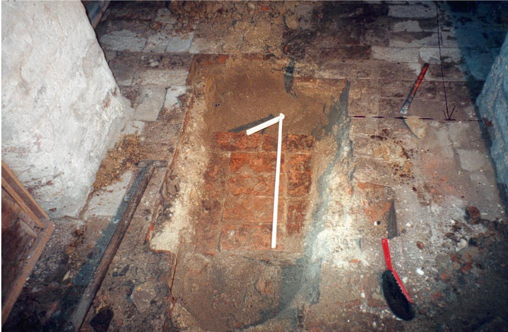
Abb. 94: Grabung 14: Pfeilerwand zwischen Kellern K 21 (oben) und K22 (unten); 2 \_ Stein breites Fundament der ursprünglichen Kelleraußenwand; Strichlinie vor dem Meißel gibt die Nordkantenflucht an, die um \_ Stein gegenüber der bestehenden nach Süden verspringt (s. Abb. 95)
