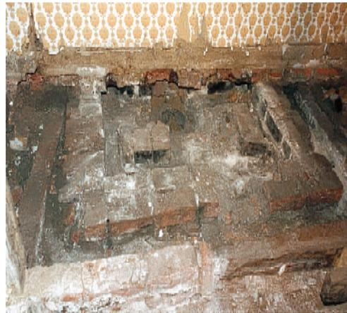
Abb. 34 und 35: Isometrie der Brennkammer unter Krankensaal und Remter (PR & Partner<sup>90</sup>) sowie Unterflurwarmluftkanäle mit kreisrundem Hauptverteilungsauslass (obere Bildmitte des Fotos von Nov. 1990 und der Isometrie).
