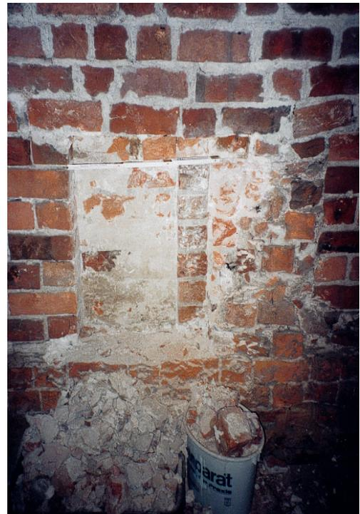
Abb. 67: Im Dachboden der *Neuen Küche* freigelegter Pfosten des ehem. Maßwerkfensters mit linker Lanzette
