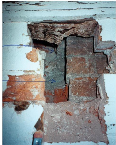
Abb. 73: Flachbogennische vor Oculus unterhalb der Decke partiell geöffnet; (beachtenswert die herunterhängende Bastunterlage des Streichbalkens, die als Feuchteschutz gegen das Mauerwerk gedacht war)
