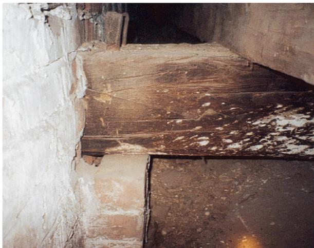
Abb. 83: Schräge Hakenblattverbindung des großen Längsunterzuges mit Holznagel auf der Wand zwischen den Räumen E17 und E21 oberhalb des Tonnengewölbes von E21
