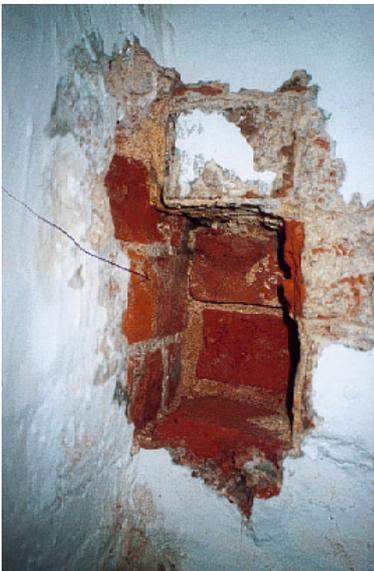
Abb. 99: Anschluss der Wand Q (rechts, Westseite) an Nordfassade (links) ohne Verband
