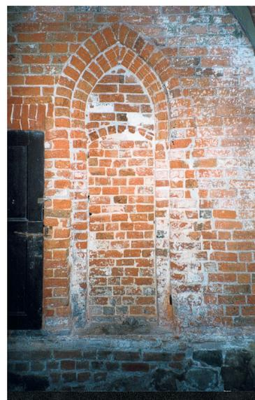
Abb. 108: Ostkreuzgang, nördlichstes Joch, ehem. Tür zu E29 nachträglich eingebrochen (Baufuge rechts, MW links später)
