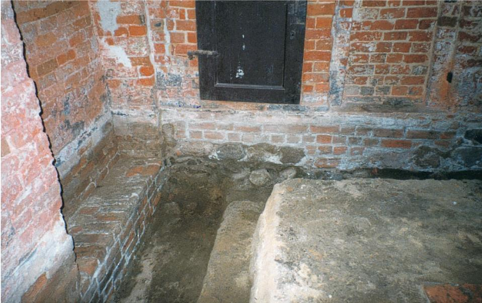
Abb. 109: Grabung 6; links Nische 16 (s. Abb. 107) des Nordkreuzganges mit flachen Steinformaten unter Nischenbank; OK Nischenbank etwa OK 1. Fußboden
