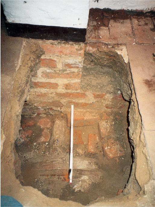
Abb. 98: Grabung Nr. 11, Reste des östlichen Stützenfundaments in spätere Wand eingemauert
