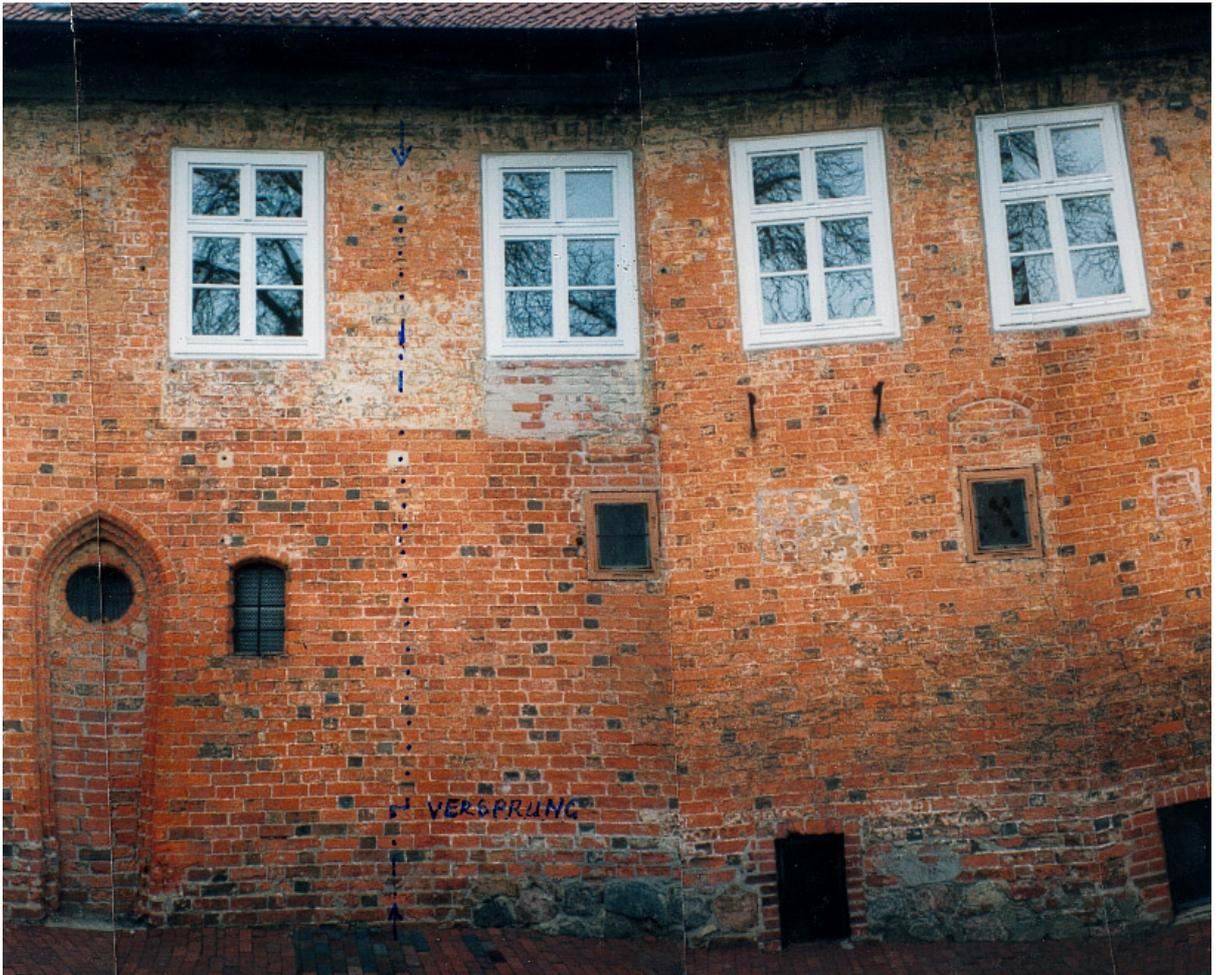
Abb. 86: Ostfassade des Ostflügels (zusammengesetztes Foto), links die ehemalige Tür zum Raum E29 (s.a. Abb. 87); die Punktlinie deutet auf die Baunaht hin (Punkte jeweils auf den Läufern zwischen den Bindern)
