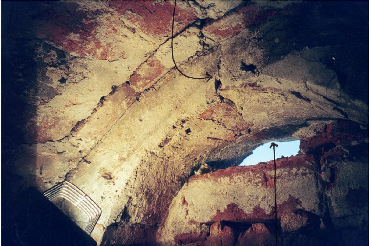
Abb. 71: Laibung des Oculus von innen; unterer Pfeil zeigt auf äußere Hälfte des Gipsschlämmenüberzuges, der sich mit seiner Verschmutzung deutlich von der inneren Hälfte absetzt. Annahme: Trennung ehemals durch Bleiverglasung
