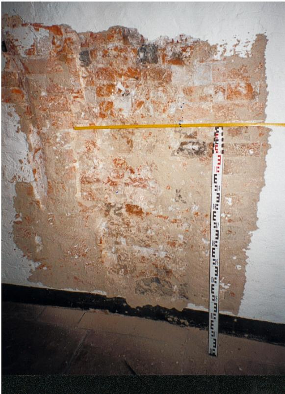
Abb. 92: Weltkartenraum, Wand Q, freigelegte Abbruchnaht bestätigt ehemalige Weiterführung der Südwand des Refektoriums nach Westen; links (=Norden) die vor- und zurückspringenden Schichtenpakete des später angefügten Mauerwerks; rechts dagegen normaler Verband
