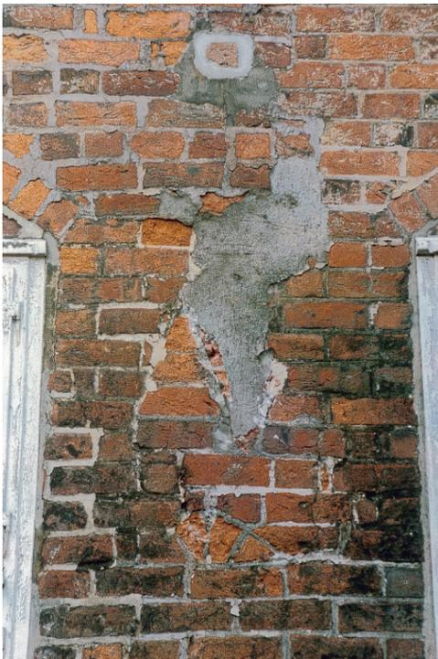
Abb. 66: Fries- und Fensterreste unter Putz aufgedeckt (zwischen 6. u. 7. großem Fenster von Osten); Aufnahme 1986 nach Freilegung durch den Verfasser
