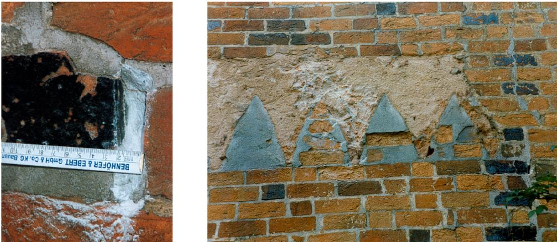
Abb. Nr. 36 und 37: Nordfassade, glasierte Eckbacksteine und Friesrest an Bauabschnittsfuge (oberhalb des Frieses gestört) bei ca. 73 m: Geöffnete Stoßfuge zeigt, dass Glasur um die Ecke läuft.
