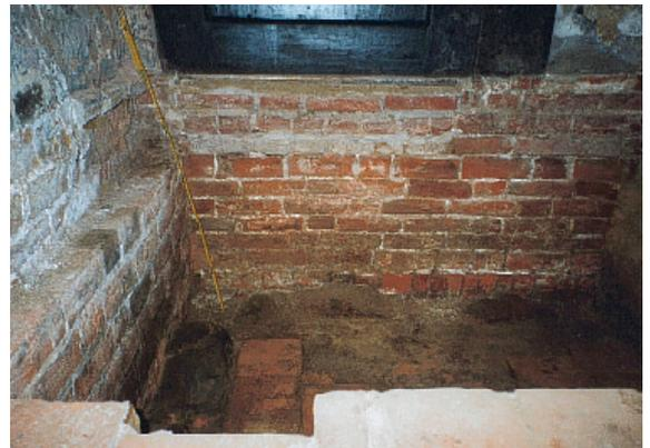
Abb. 82: Grabung 3 an Osttür und Trennwand zur A. Küche: 1. Fußboden; rechte Laibung ursprünglich 3 Schichten tiefer - passend zum 2. Fußboden: Vertikalfuge
