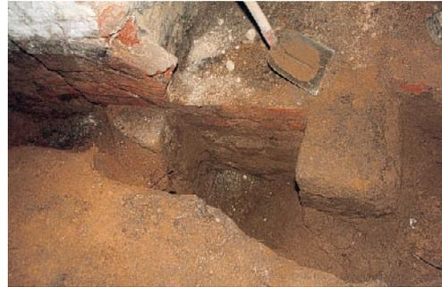
Abb. 31: Ausguss in die Schwienuau beidseitig von auskragenden Granitsteinen eingefasst, auf denen ein Backsteinbogen aufgesetzt war (links sind noch 3 Bogensteine zu sehen), um das Wasser unter dem aufgehenden Mauerwerk austreten zu lassen, s. Abb. 29
