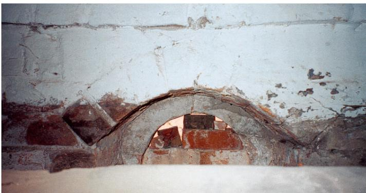
Abb. 70: Raumseitiger Flachbogen über Oculus in Deckenebene des *Alten Refektoriums* (= unmittelbar über Fußboden des Obergeschosses)
