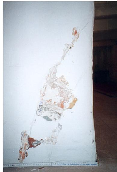
Abb. 100: Durchgang durch die Wand Q im Zwischengeschoss; Rest eines ehemaligen Spitzbogens über dem Fußboden auf der Ostseite
