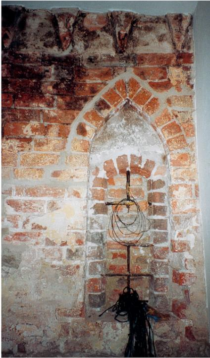
Abb. 64: Freigelegtes Fenster in *Neuer Küche*, Flachbogenfenster mit Spitzbogenblende später eingefügt
