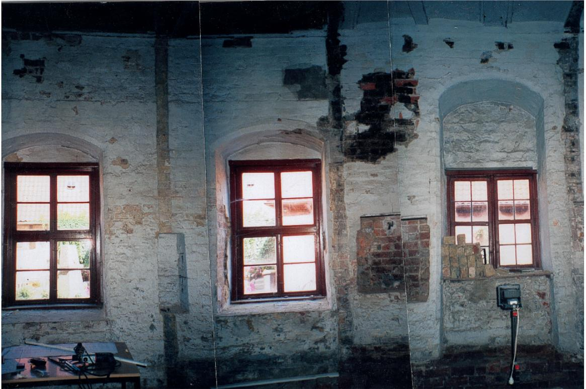
Abb. 79: (Fotos zusammengesetzt) Altes Refektorium, Fenster 3, 4 und 5 von Osten (rechts): horizontale Baufuge 2 Schichten über den Fenstern 4 und 5; die drei östlichen Fenster (1-3) wurden nachträglich erhöht (die Anfängersteine der alten Höhe sind noch feststellbar); auf den 3 Fensterpfeilern noch gut die Anschlüsse der abgebrochenen Fachwerkquerwände erkennbar
