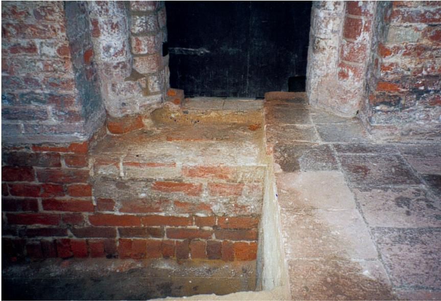
Abb. 106: Der Eingang der *Alten Küche* lag ursprünglich um 3 Schichten niedriger (Vertikalfuge unter der linken Laibung). Mit einer Stufe wurde der 1. Fußboden im Kreuzgang beim Austritt erreicht
