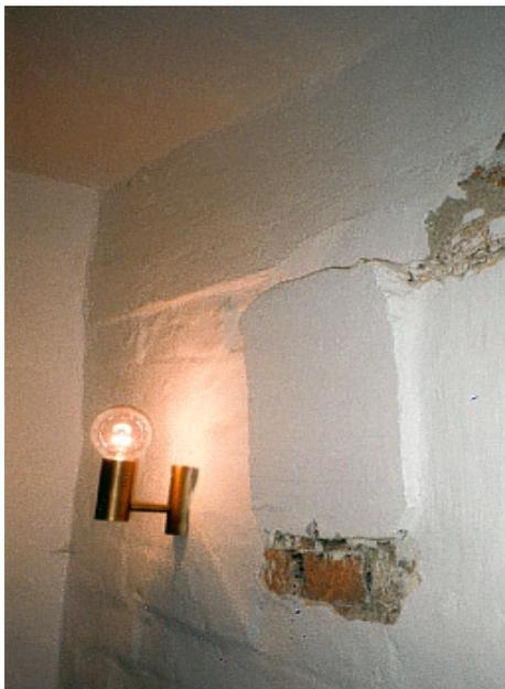
Abb. 90: Nachträglich abgesägter Unterzug in der Ostwand von E16
