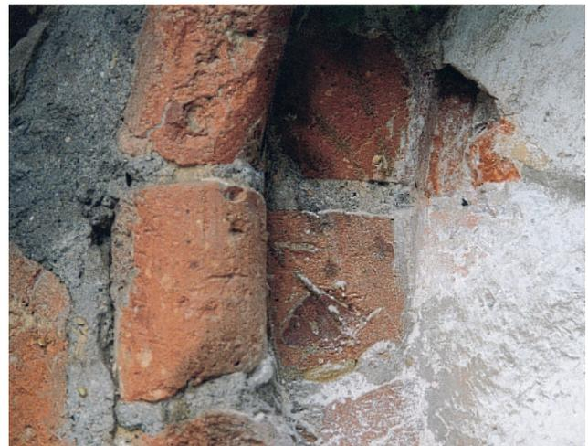
Abb. 78: Wie Abb. 77, Oculus-Formstein mit freigelegtem Glasanschlag; links vergrauter Fugengipsmörtel
