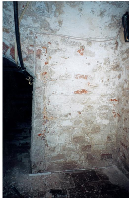
Abb. 93: Flachbogenanfänger auf nachträglicher Mauervorlage von  $\frac{1}{2}$  Stein Dicke: Durchlaufende Vertikalfuge, dunklere Färbung der Vorlage
