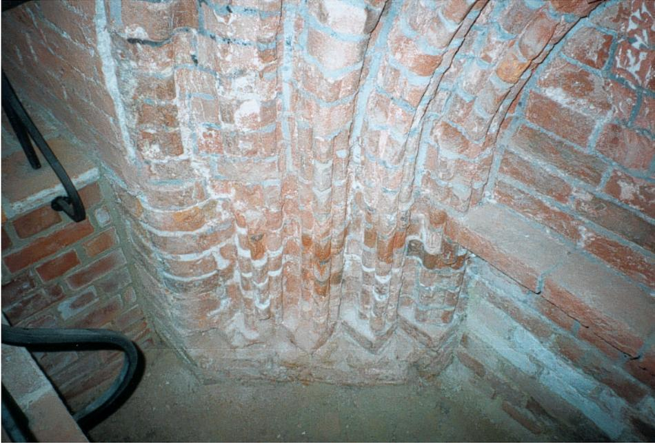
Abb. 47: Südliches Doppelportal des ehem. Kapitelsaales mit 5-fach zurückgestufter Laibung: *Scharfes Birnstabprofil des 13. Jh.s*
