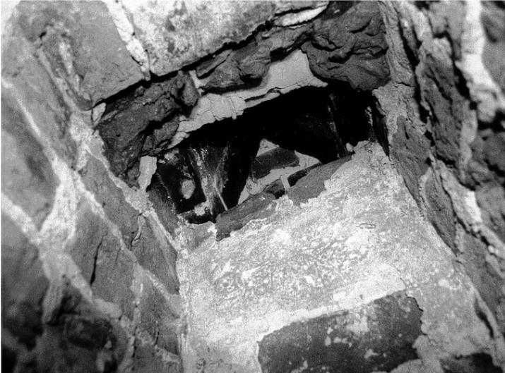
Abb. 45: *Altes Refektorium*, E 16, Südwand; Durchbruch zur ehemaligen Kreuzgangnische (in 3. Spitzbogennische) mit 5 cm auskragendem Stein unter der Spitze; deutliche Rußspuren; nach kreuzgangseitiger Vermauerung wurde Nische refektoriumsseitig durchgebrochen und rückseitig mit Gipsschlämme überzogen, wie hier gut zu sehen ist
