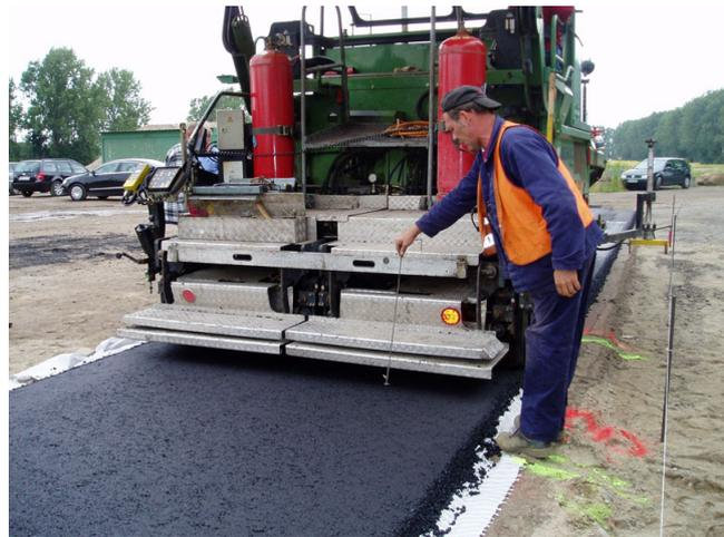
**Abbildung 3.8:** Einbau der Binderschicht mit einem Straßenfertiger
