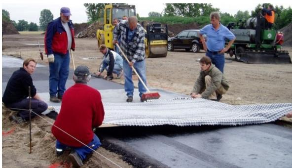
**Abbildung 3.7:** Verlegen der Asphalteinlagen
