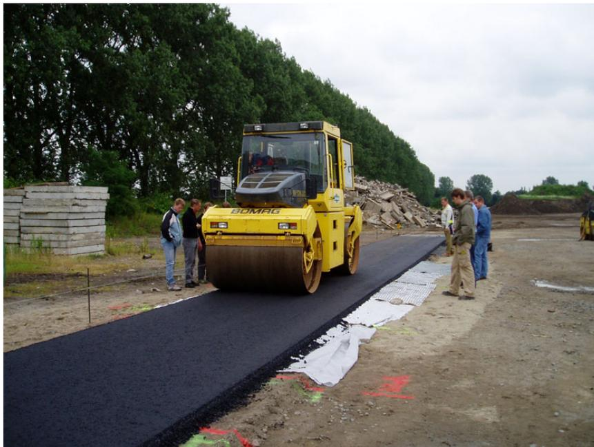
**Abbildung 3.9:** Verdichten der fertigen Binderschicht
