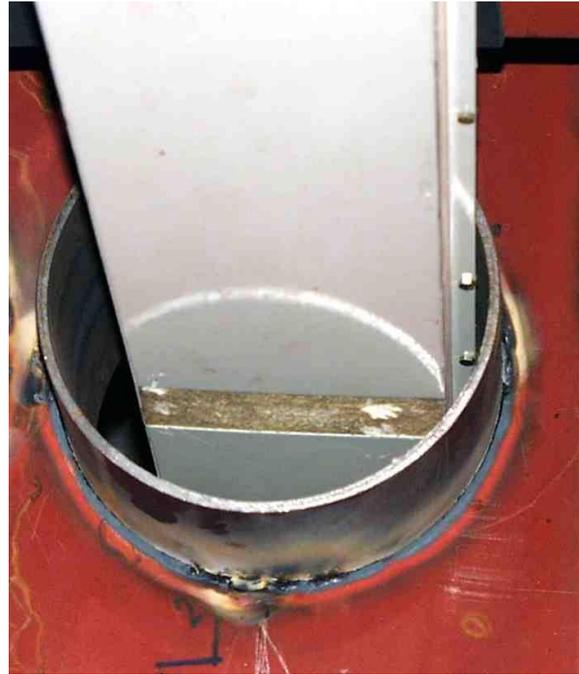
Abb. 28: Maßgenau geplante und herstellerseitig im Schienenkasten eingesetzte Brandabschottung im Durchführungsstutzen (noch offen)
