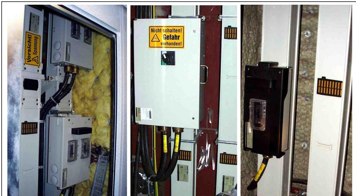
Abb. 29: Beispiele Steigleitungs-Stromschienen mit Abgangskästen
