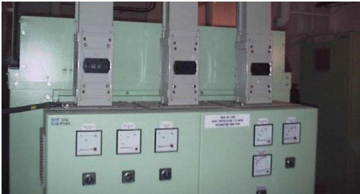
Abb. 24: Anbindung der steuerbord- und backbordseitigen Steigleitungs-Stromschienen an die niederspannungsseitigen Abgangsfelder einer Transformatorstation einer Feuerzone
