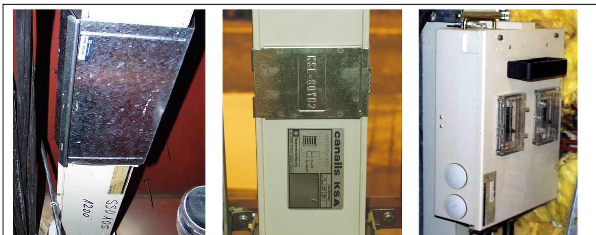
Abb. 8: IP54 Abdeckungen für Verbindungsstellen (links), IP54 Abdeckung für nicht benutzte Abgangsstellen (Mitte) und Abgangskästen in IP54-Ausführung (rechts)
