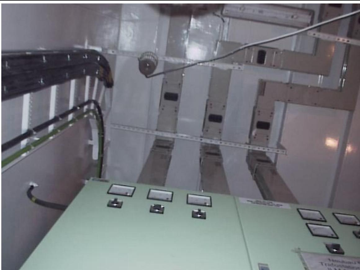
Abb. 26: Ansicht zu Decke: Stromschienenführung mit Winkelkästen, links im Bild: Notkabel zu angrenzenden Transformatorstationen
