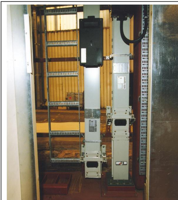
Abb. 20: Steigleitungsschacht Musteraufbau mit zwei Stromschienen und Kabeltrasse
